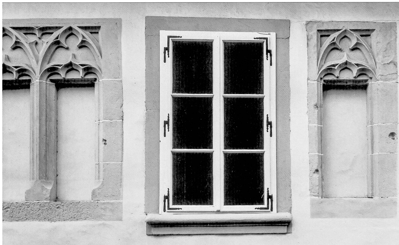
aveugles du deuxième étage de la façade côté Stalden de la maison n° 2, datés de 1366 grâce à l'analyse dendrochronologique des bois insérés dans les maçonneries d'origine
