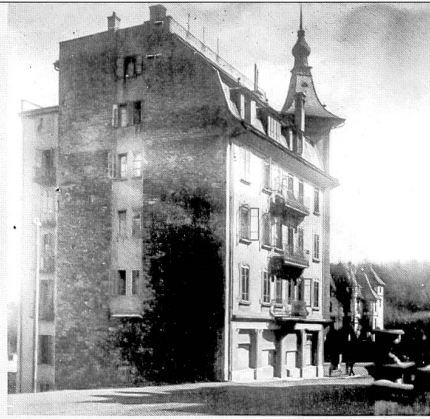
Vue de l'immeuble à la fin du chantier (ASBC)
