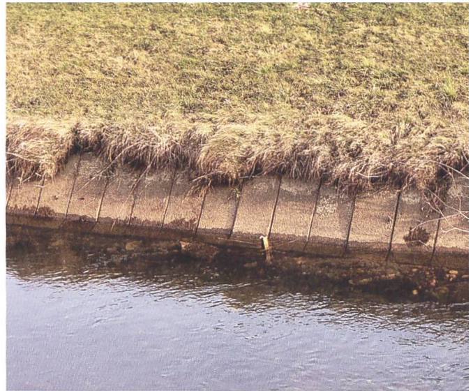
Typisches Erscheinungsbild des Hauptkanals: Ein schnurgerades Bachbett (Bild links) und Betonplatten in der Uferböschung (Bild rechts).
