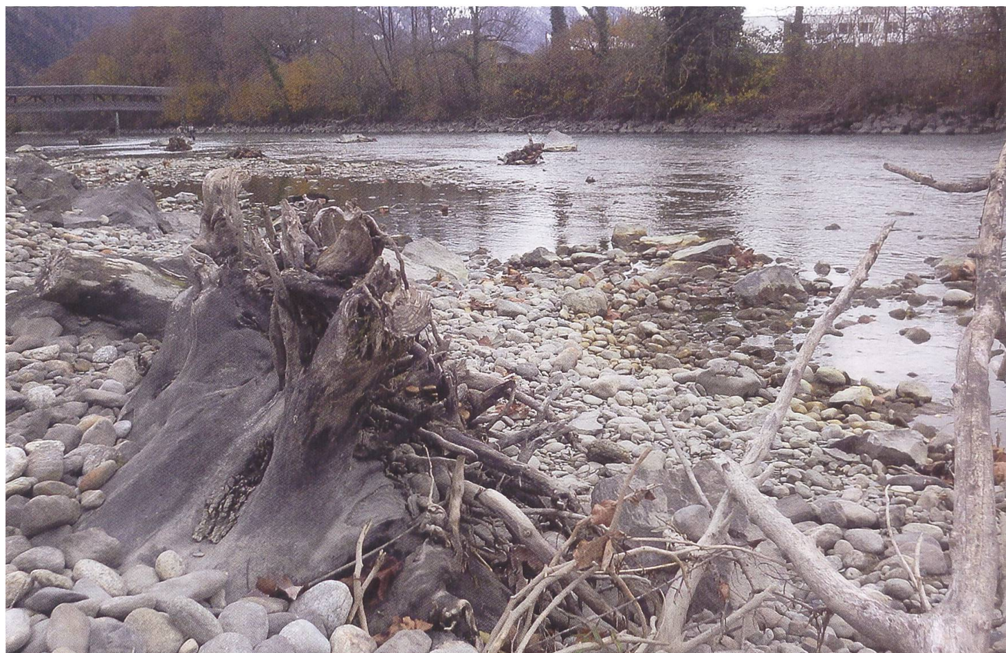
Beispiel für Wurzelstöcke als Renaturierungsmassnahme (Bödeliaare bei tiefem Wasserstand).
