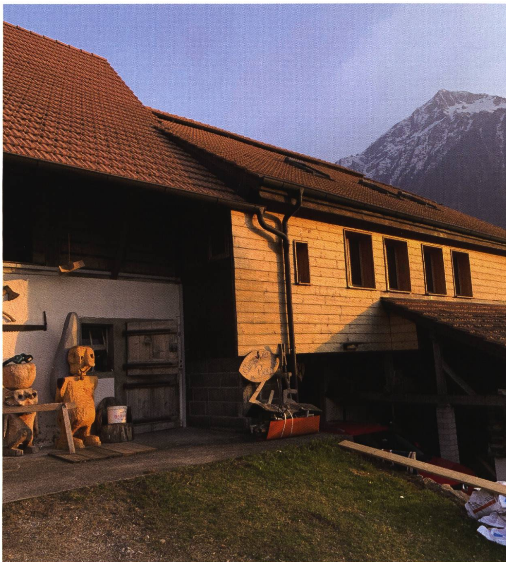
Übergang von der Scheune in den Wohnteil
