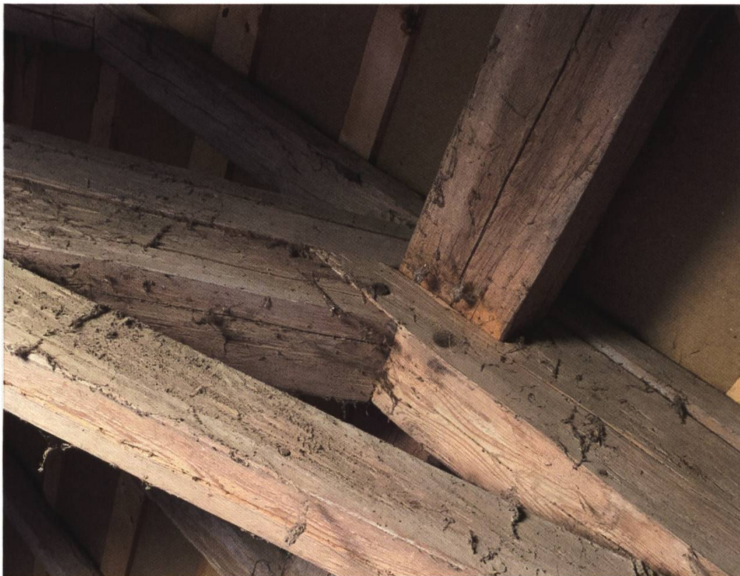
Beispiel für Holznagelverbindungen
