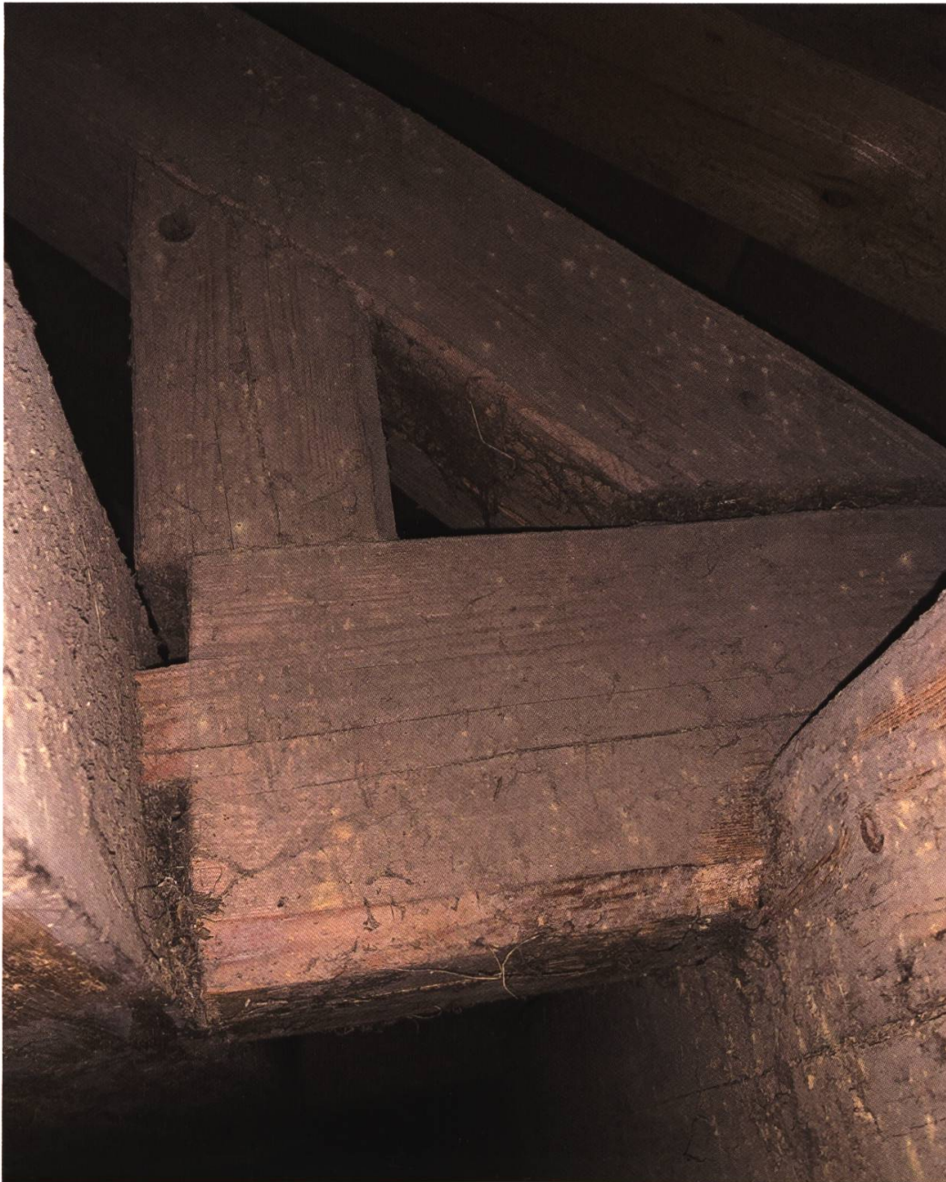
Zapfenverbindung in der Scheune
