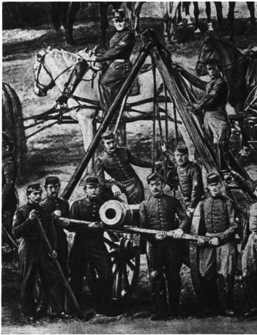
Dreibein mit Seilwinde, 900 kg-Geschütz
