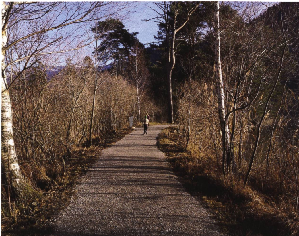
Uferweg Weissenau, Dammschüttung (Foto: Andreas Fuchs)
