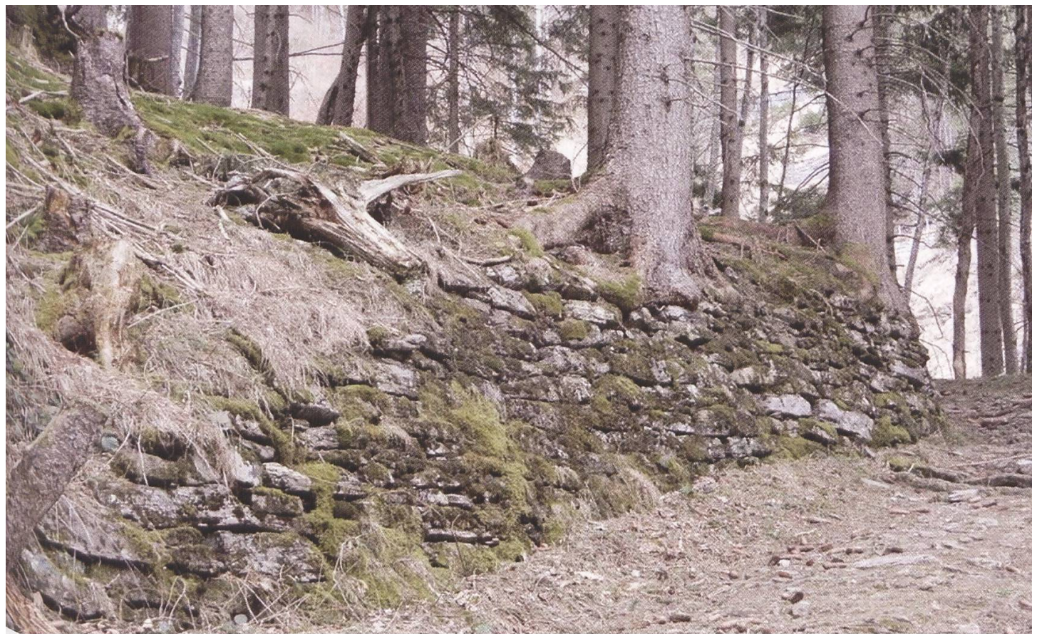
Trockenmauer oberhalb von Chälen
