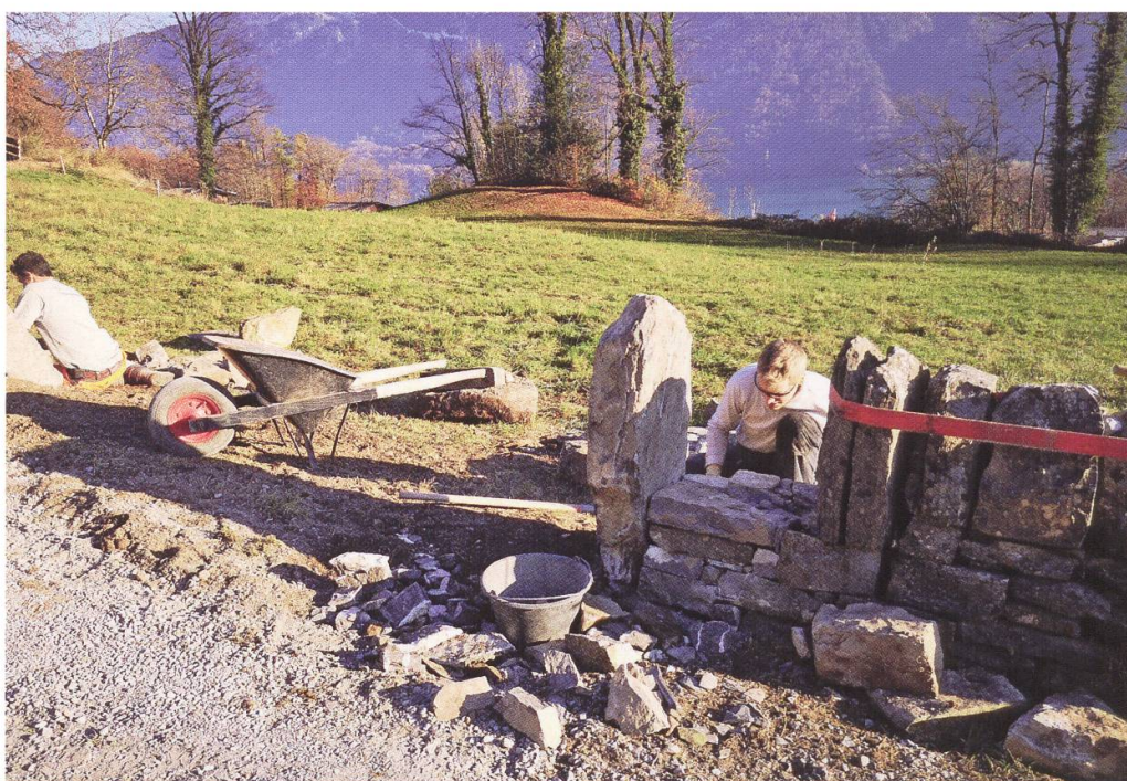
Trockenmauerspezialisten an der Arbeit (Andreas Fuchs)
