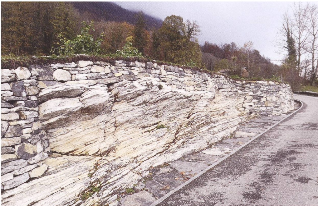
... und nach der Sanierung (Andreas Fuchs)
