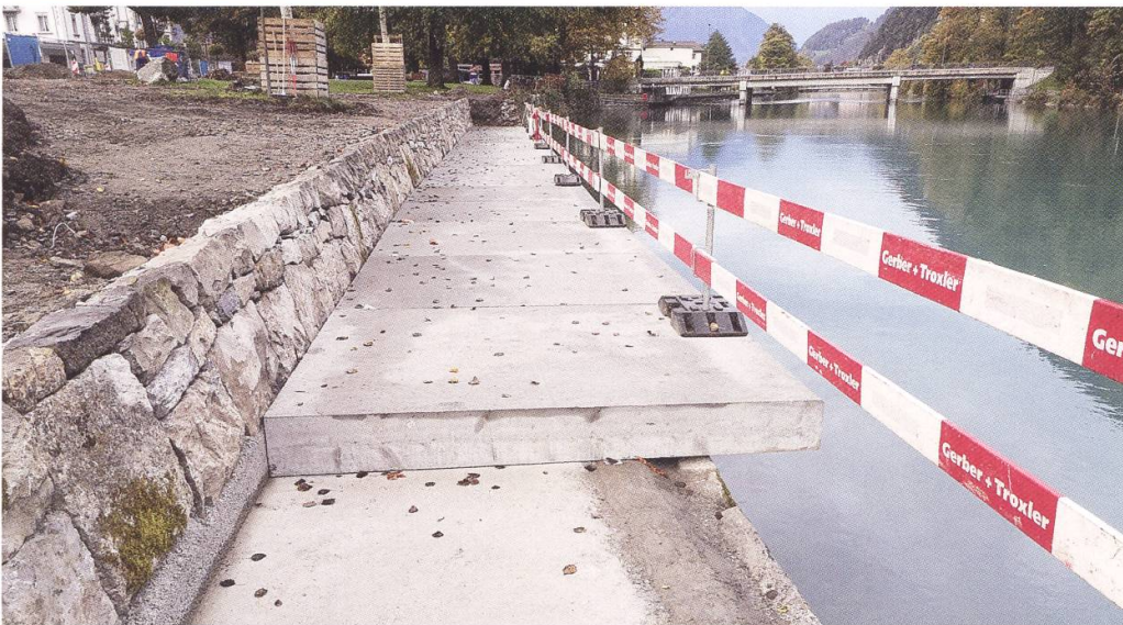
Die denkmalgeschützte Ufermauer wurde für den versenkten Quai zurückversetzt. (Andreas Fuchs)
