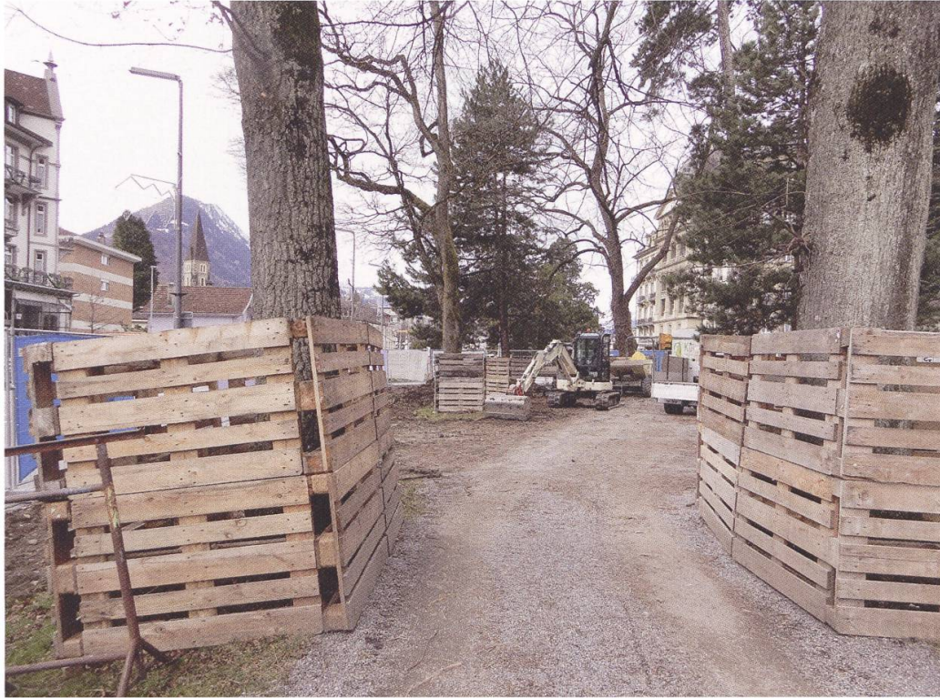
Die alten Bäume waren während der Bauarbeiten gut geschützt. (Sibylle Hunziker)
