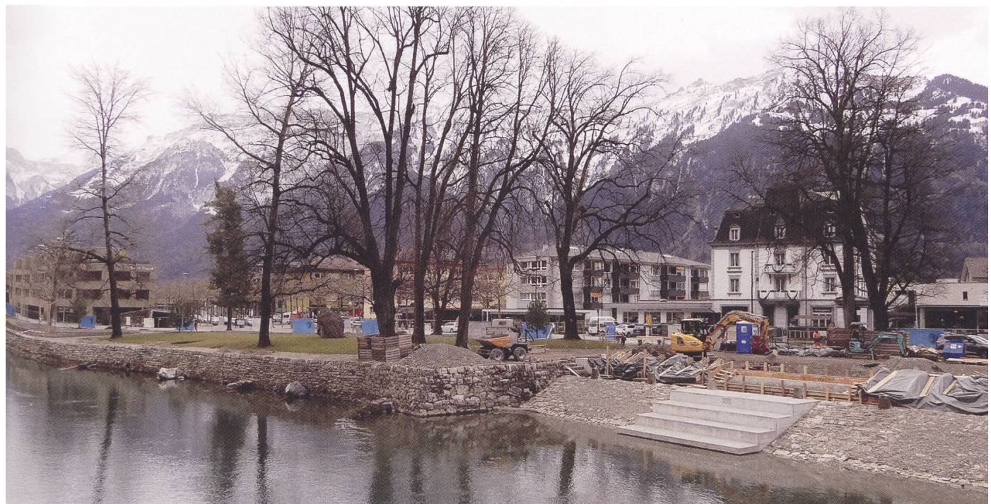
Die Baustelle im Februar 2020 (Sibylle Hunziker)
