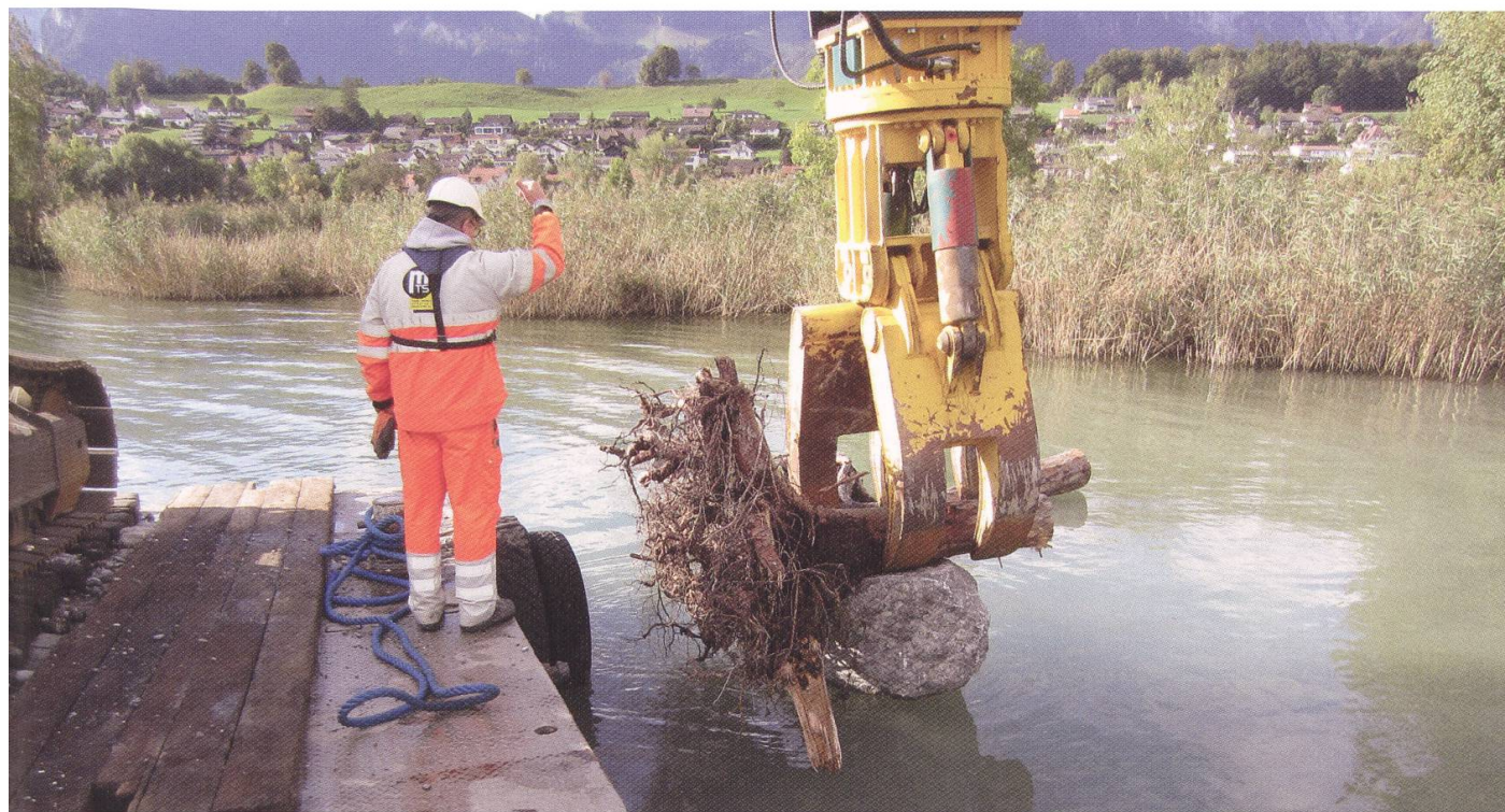
Einbau der Wurzelstöcke (Kissling + Zbinden)
