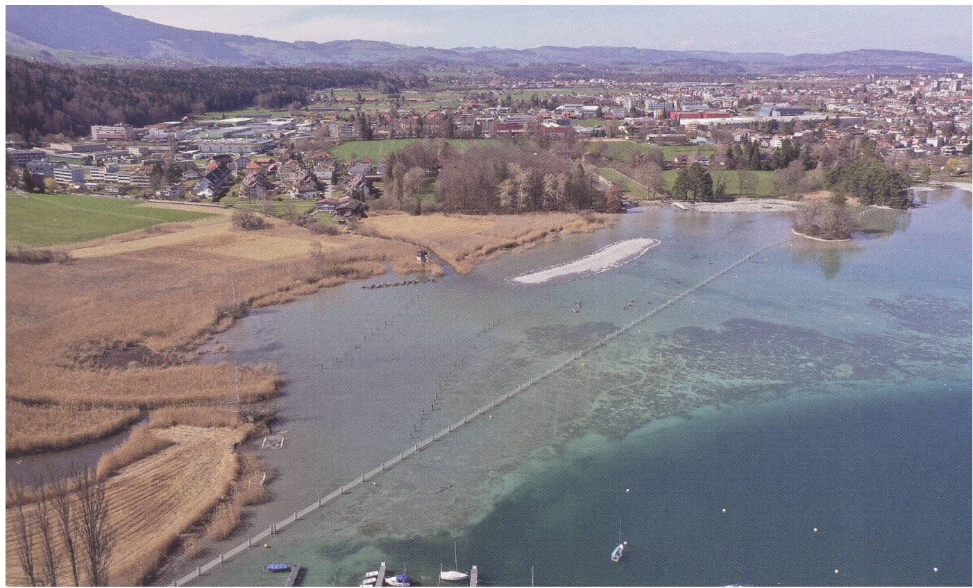
Übersicht über den Endzustand (Kissling + Zbinden)
