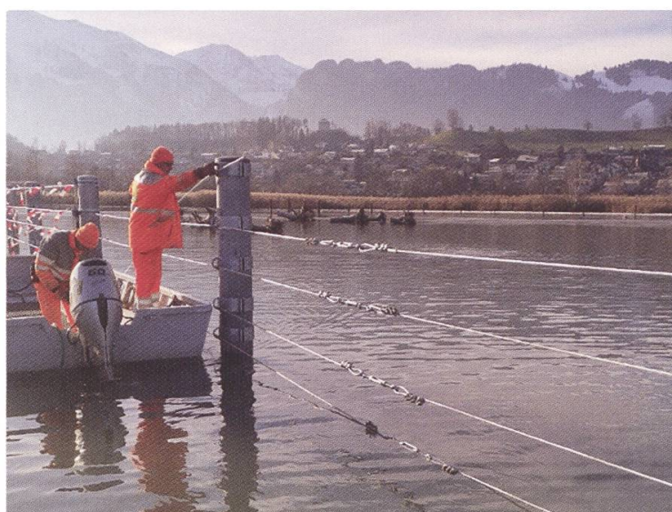
Links: Pfählungsarbeiten (fu) und rechts: Spannen der Tragseile (Kissling + Zbinden)
