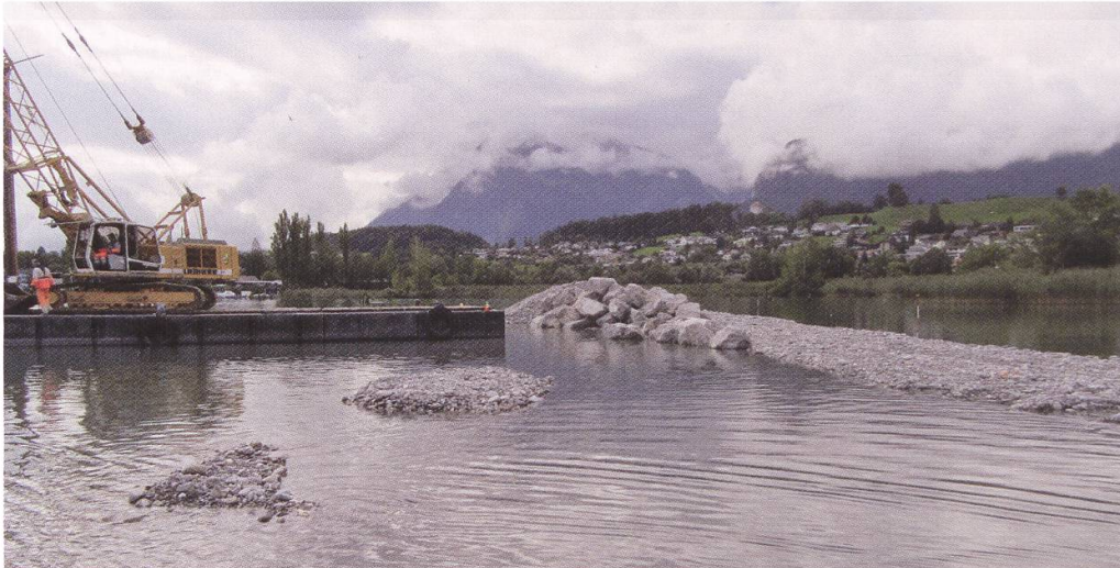
Riffschüttung mit Fusssteinen (Kissling + Zbinden)
