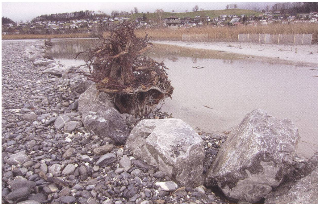
Fussteine der Riffschüttung, uferseitig, während der ausserordentlichen Seeabsenkung. Im Hintergrund: Die eingezäunten Schilf-Initialpflanzungen. (Kissling + Zbinden)
