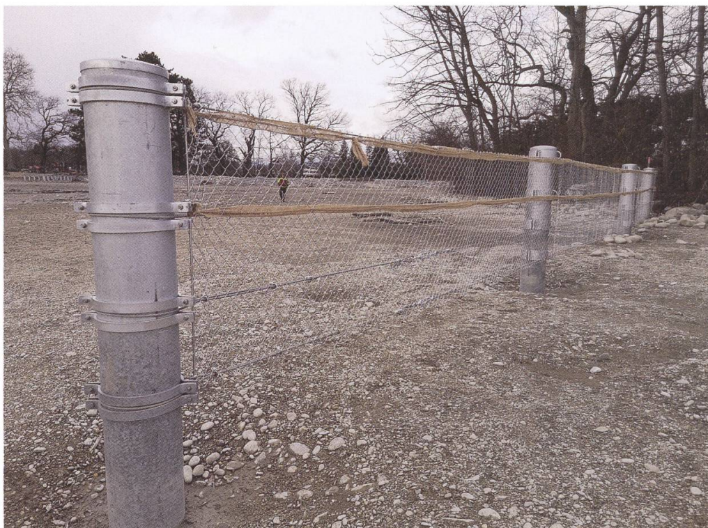
Pfähle mit dem Netz, das an Eck- und Endpunkte fix montiert ist (vorne), dazwischen flexibel (im Hintergrund) (fu)
