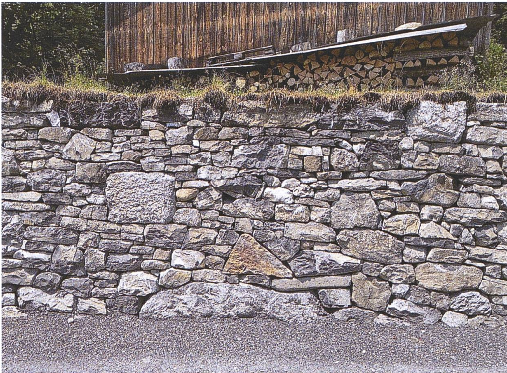
Trockenmauer am Pilgerweg: Handwerkskunst mit alten Steinen
