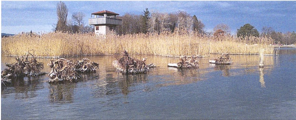
Totholzstrukturen als Wellenbrecher im Gwattlischenmoos
