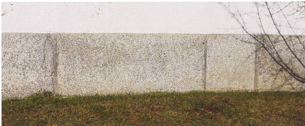
Abb. 19: Die ganze Kirche steht auf massiven Granit-Sockelsteinen. Dieser Granit weist eine feinere kristalline Struktur auf als der Granit der Fensterumrandungen («Granodiorit»). Es könnte sich dabei um den «Zentralen Aaregranit» aus dem unteren Haslital handeln. Es ist somit denkbar, dass die beiden Findlinge in Wachseidorn aus verschiedenen Graniten bestanden (Foto: Alfred Hänni).
