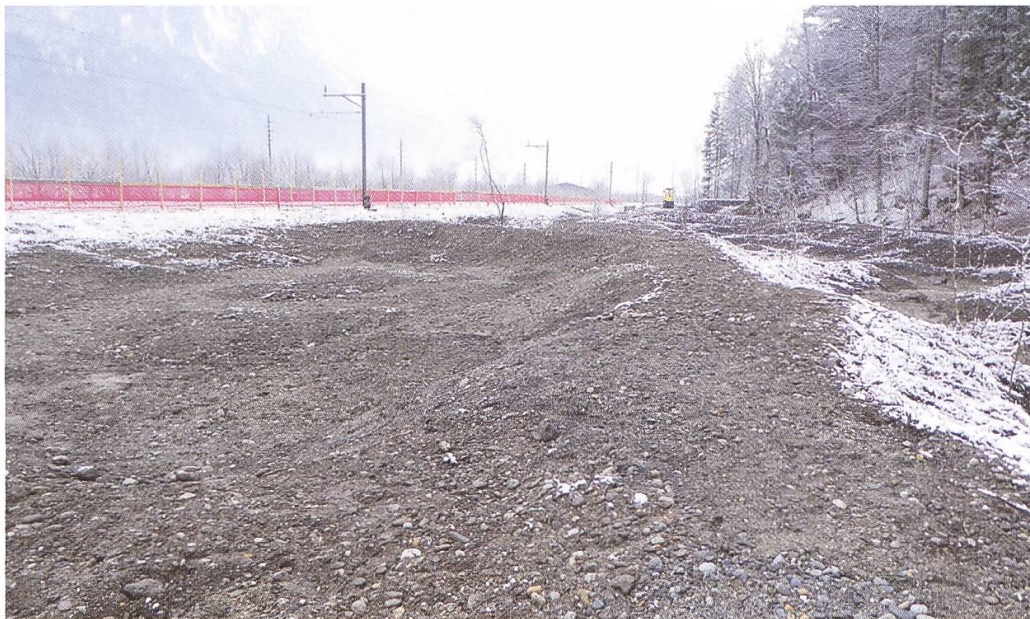
Bau der neuen Unkentümpel im Winterhalbjahr: Zwischen Bahn (links im Bild) und dem neuen Bachlauf des Hüsenbachs (rechts im Bild) entsteht eine neue Tümpellandschaft. (Foto: Daniela Schmocker, IMPULS AG Wald Landschaft Naturgefahren)
