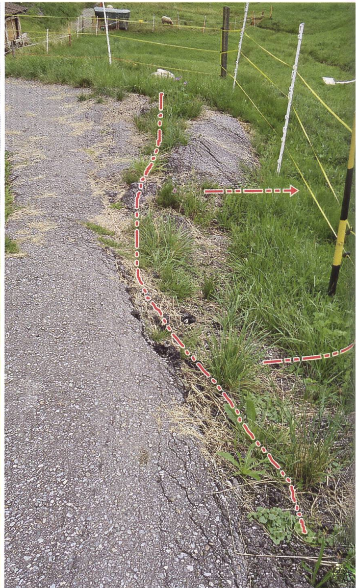
Abbildung 24: Abriss im Belag
