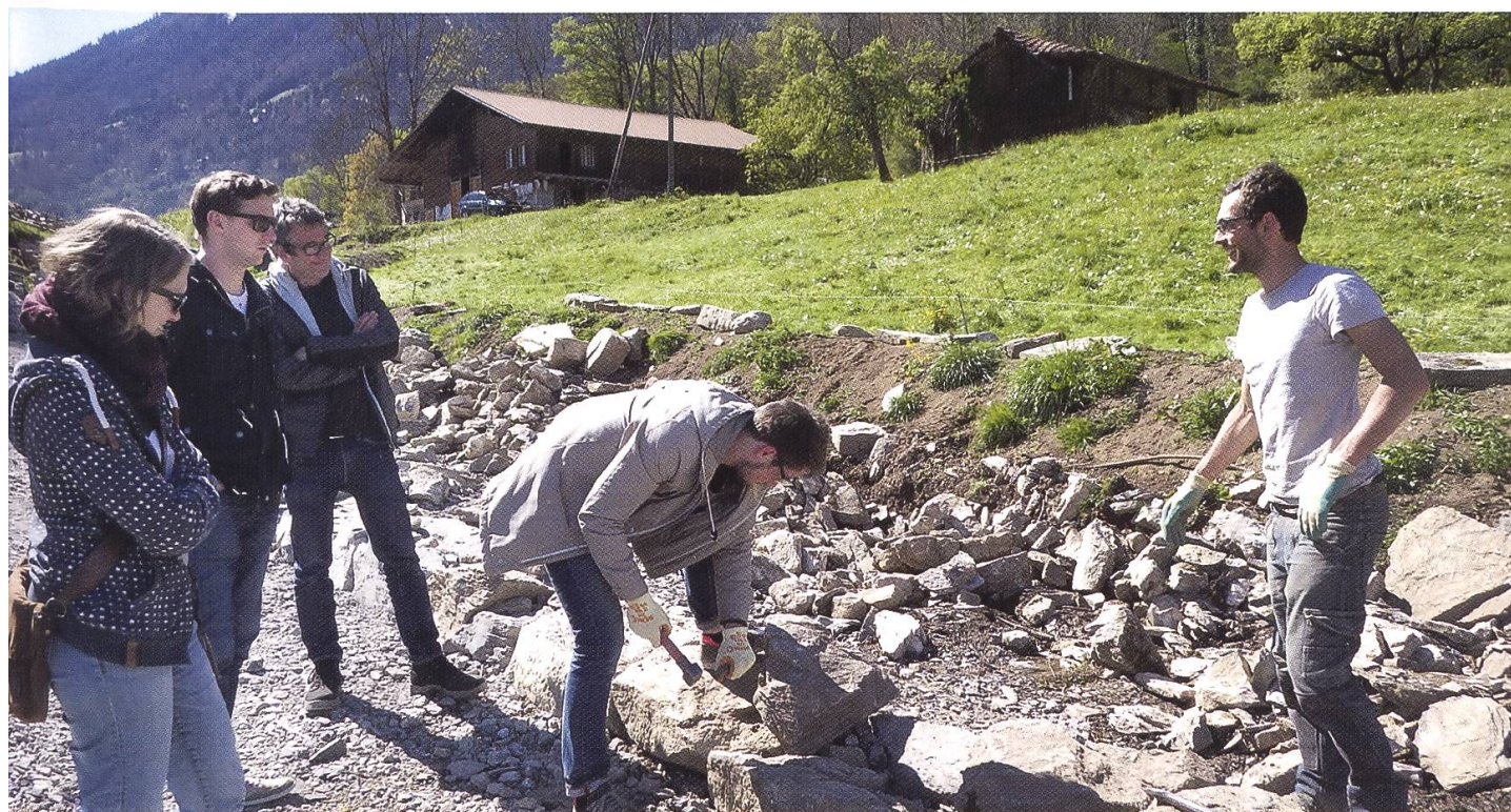
Besucher beteiligen sich am Trockenmauerbau.
