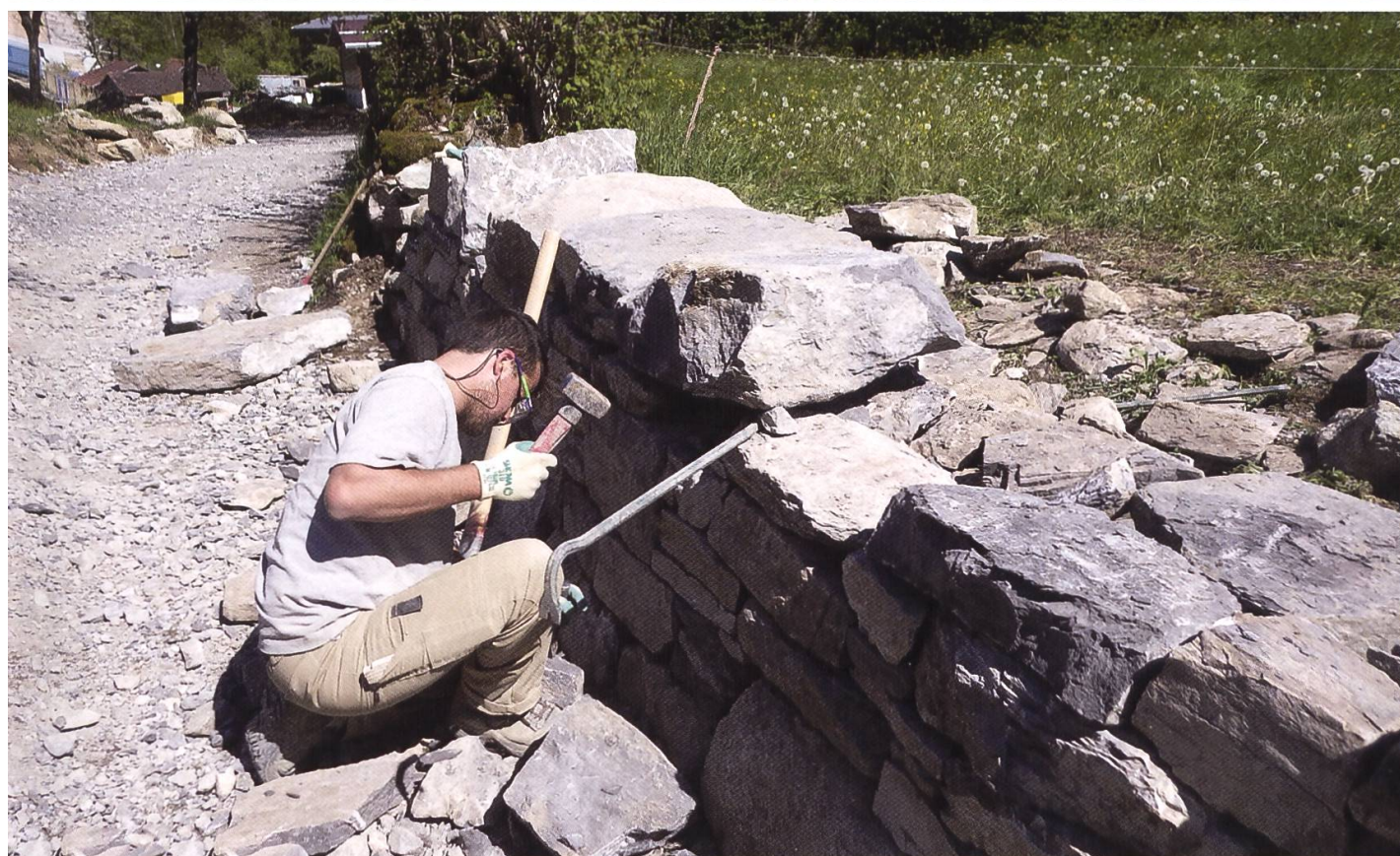
Rund einen Quadratmeter Mauer baut ein erfahrener Trockenmaurer pro Tag.
