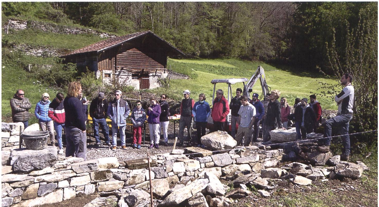
Tag der offenen Baustelle am Pilgerweg in Ringgenberg
