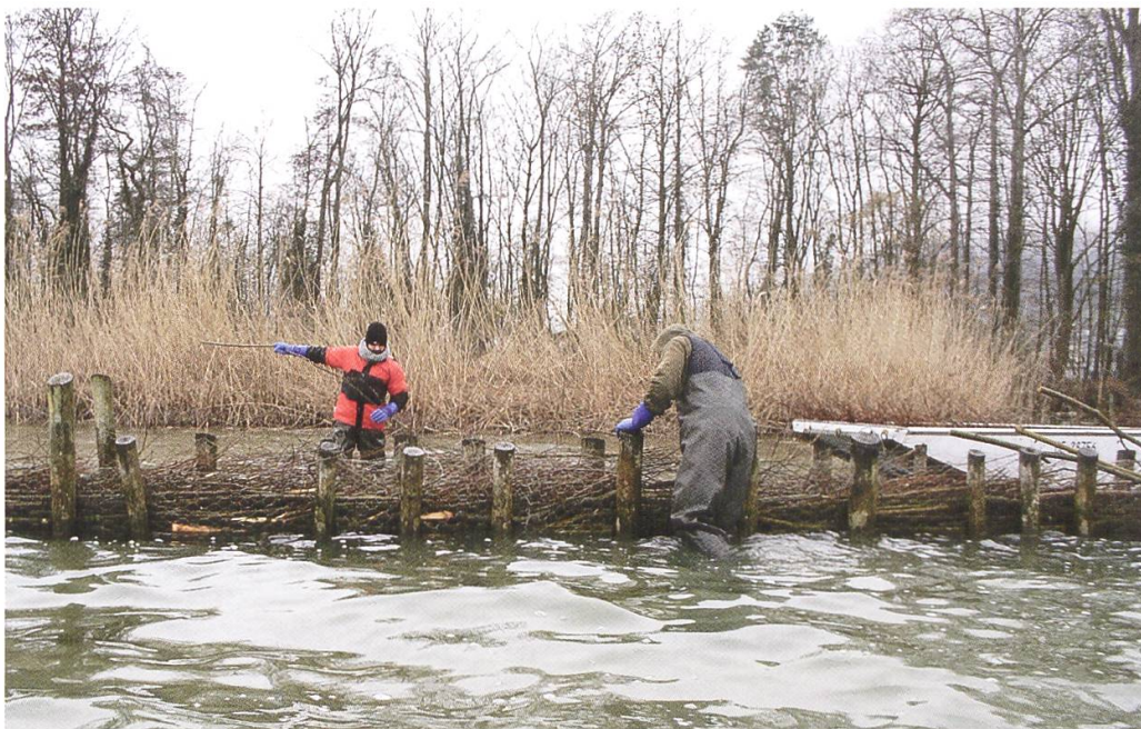
Unterhalt von Lahnungen für den Schilfschutz bei Erlach durch das Landschaftswerk Biel-Seeland. Foto: Nadja Gubser
