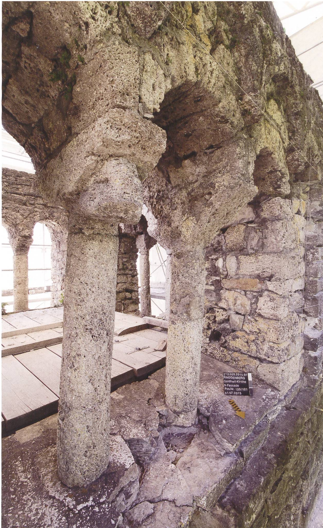
Abb. 8: Bauschäden am Tuffbestand der obersten Schallöffnung im Jahr 2015 vor Beginn der Sanierung (Foto Markus Leibundgut, ADB).
