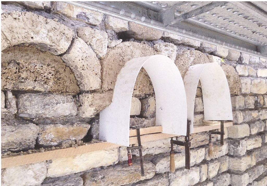
Abb. 13: Ergänzung der Blendarkaden des Turmes mit Tuffmörtel während der Sanierung Sommer 2015 (Foto Matthias Kilchhofer, Bern).
