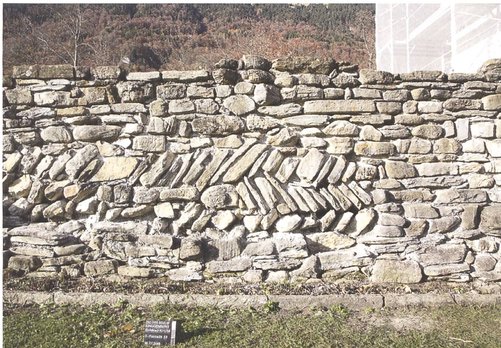
Abb. 20: Fischgrätförmiger Mauerverband in der Südwand des Kirchenschiffs (Foto Raphael Ehrensperger, ADB).
