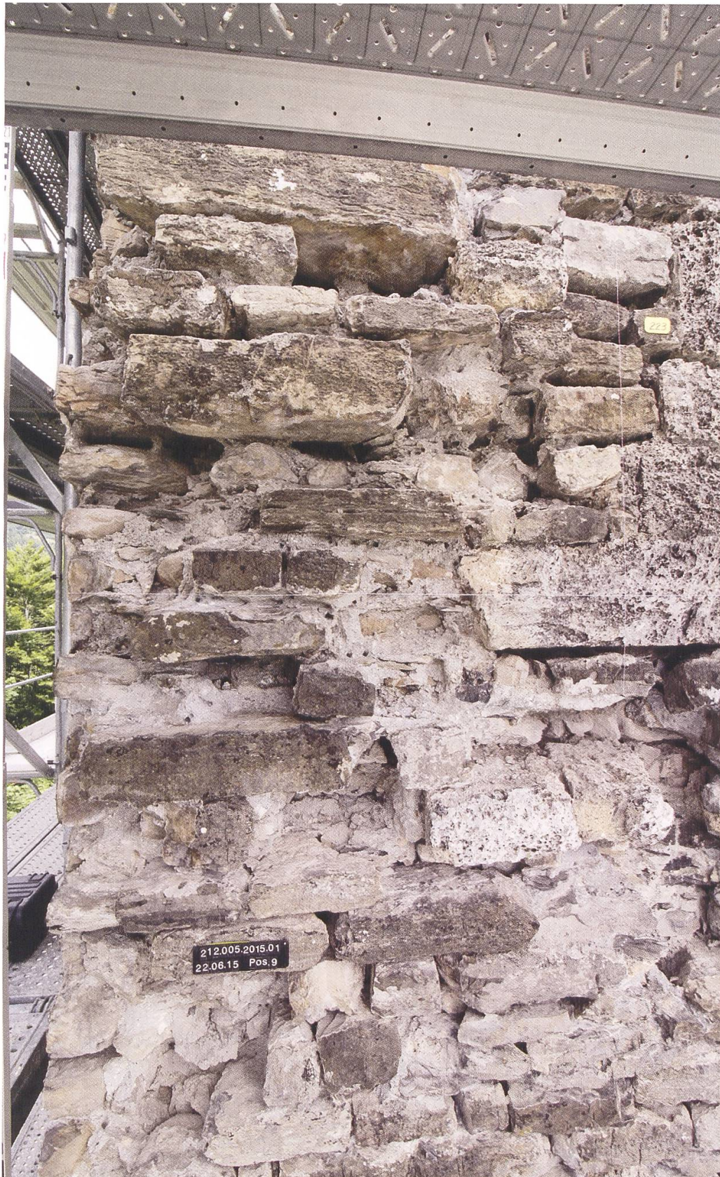
Abb. 9: Bauschäden am Quaderbestand des Turms während der Sanierung 2015 (Foto Raphael Ehrensperger, ADB).
