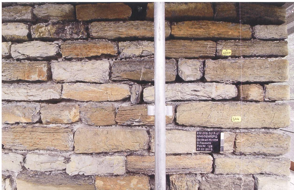
Abb. 23: Ausschnitt des Hausteinmauerwerks im Bereich der Südostecke des Campanile nach dem Freilegen der Fugen im Sommer 2015 (Foto Raphael Ehrensperger, ADB).
