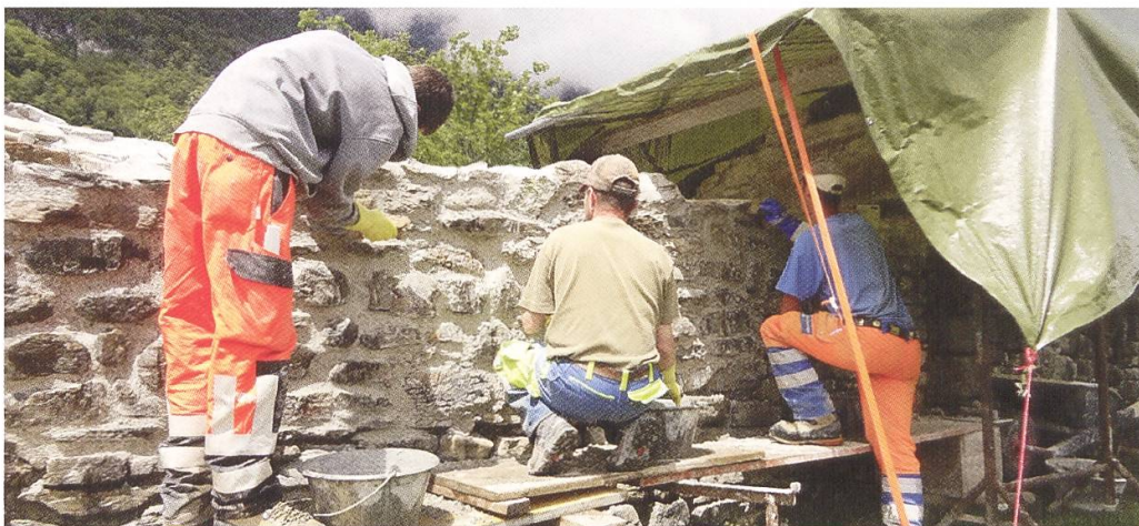
Abb. 14: Verfugen der südlichen Kirchenschiffwand im Sommer 2016 (Foto Markus Leibundgut, ADB).
