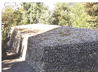
(2) Südwand und Decke
