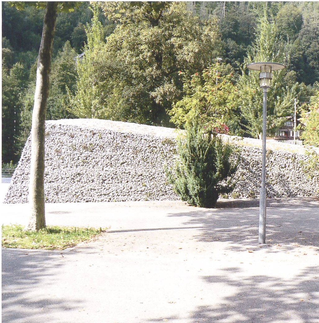
(1) Einfahrt, Seitenansicht von Süden
