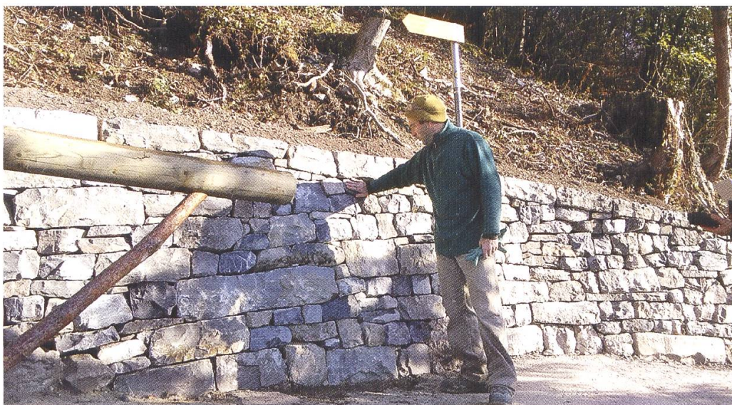
Pilgerweg Beatushöhlen, Trockensteinmauer mit Abschlusssteinen Dezember 2016, Foto: Andreas Fuchs
