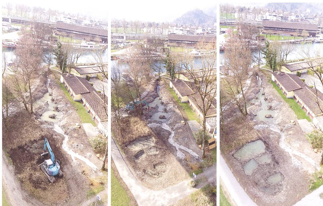
Marchgräbli Interlaken-Ringgenberg, Bauzustand Frühjahr 2016 Fotos: Mätzener + Wyss AG
