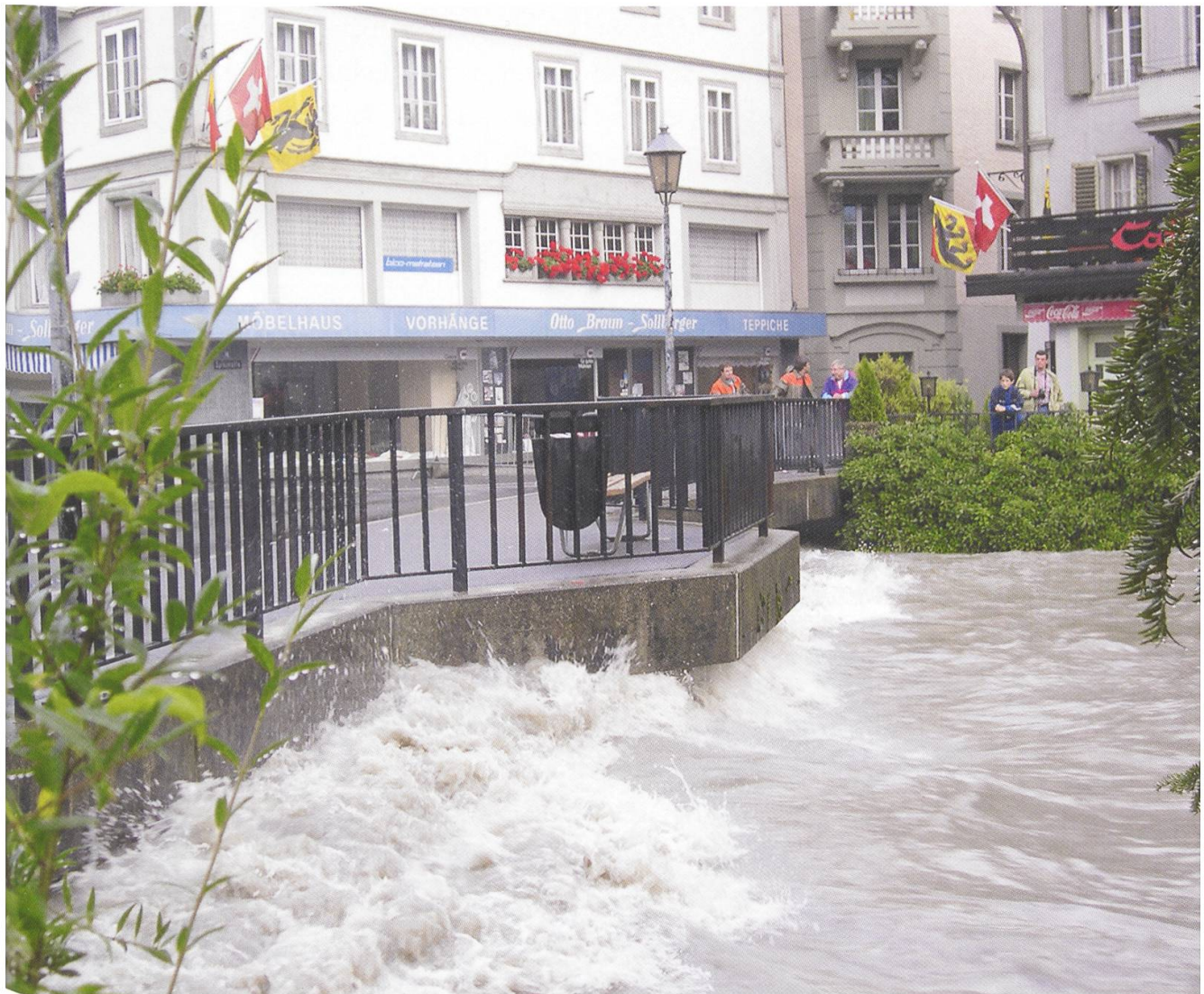
Abb. 9: Das Wasser beginnt sich an der Höhebrücke zu stauen (Foto: Alfred Balsiger).
