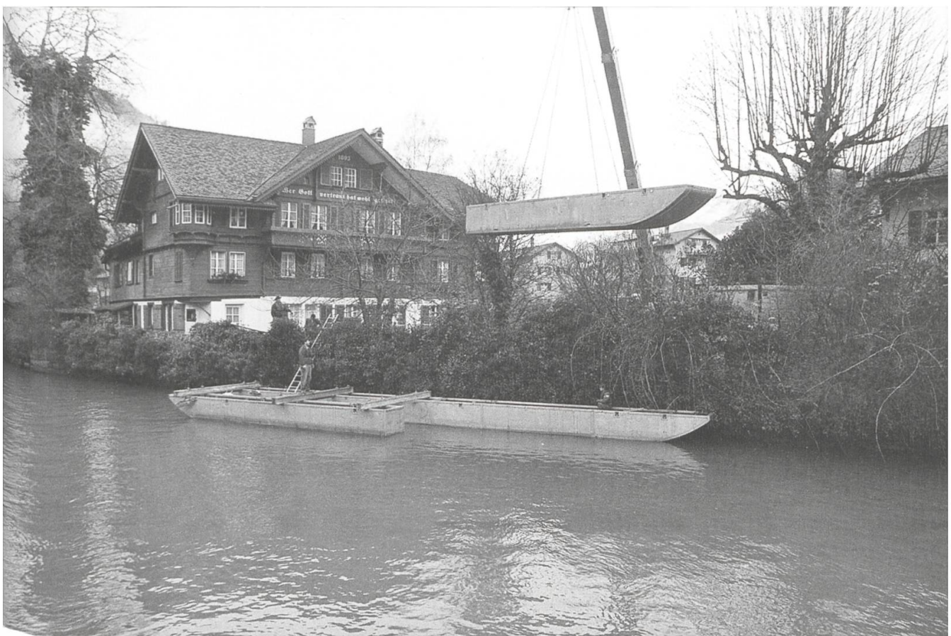
Abb. 8: Arbeitsplattform auf der Aare (Foto: Sandro Hügli).
