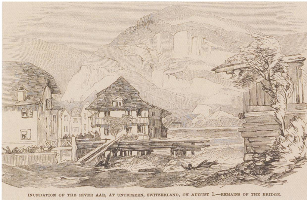
Abb. 2: Zwei Wochen nach der Zerstörung der alten «Höhebrücke» in der Überschwemmung vom 1. August 1851 berichteten sogar «The Illustrated London News» über die Verwüstungen, die den Anstoss zum Bau der Staatsschleuse gaben. (Sammlung Christoph Wyss, Unterseen)
