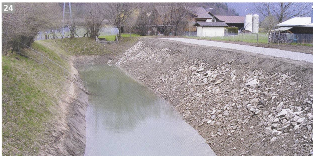
Abb. 20–24: Ersatz der Kiesfilterschicht der Versickerungsanlage im Frühjahr 2008 (Fotos: Ueli Bettschen):
