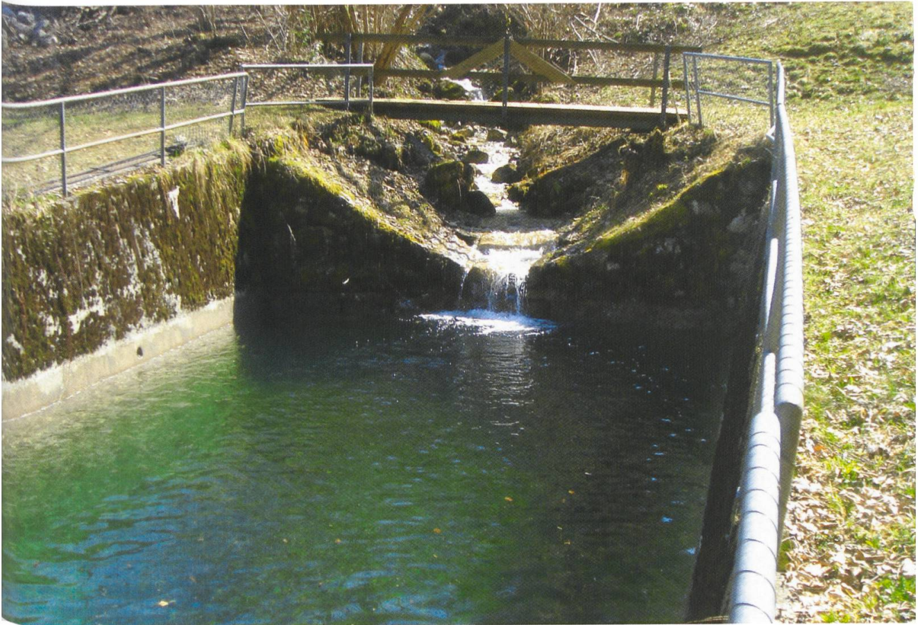
Abb. 25: Geschiebesammlung und Brücke im «Gubi» 2015 (Inhalt: 276 m 3 ).
