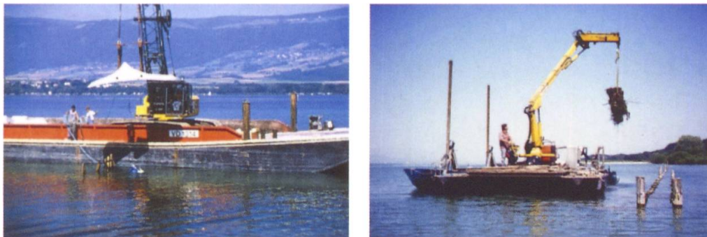
Figure 8: Aménagement d'ouvrages de lutte contre l'érosion sur le tronçon-pilote de Cheseaux-Noréaz (VD). A gauche, mise en place d'un récif artificiel en béton pré-fabriqués. A droite pose d'une palissade en pieux de bois. (Photos: collection Grande Cariçaie)
