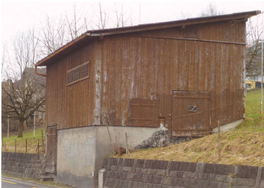
Abb. 2: Panzerabwehr-Bunker «Strasse» für eine 7.5 cm Feldkanone.
