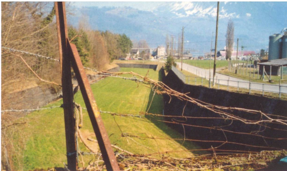
Abb. 12: Ansicht des Panzergrabens Einigen, 2000.
