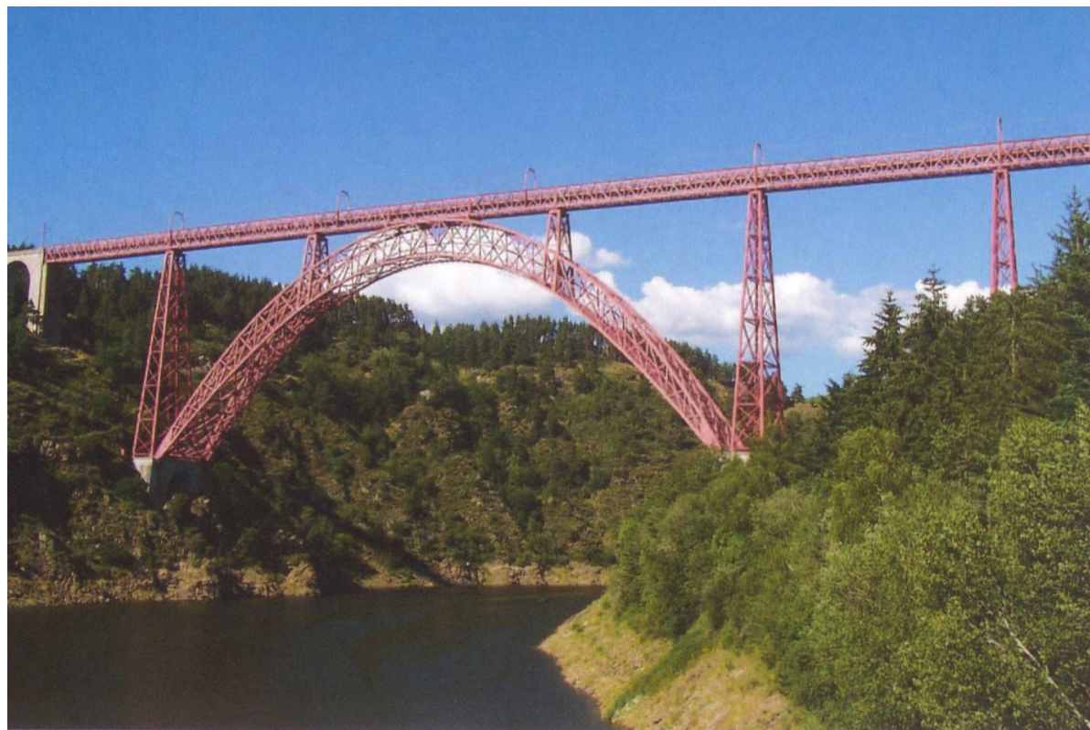
Der von Eiffel entworfene Viaduc de Garabit in Frankreich. (J. Thurion, 2005)
