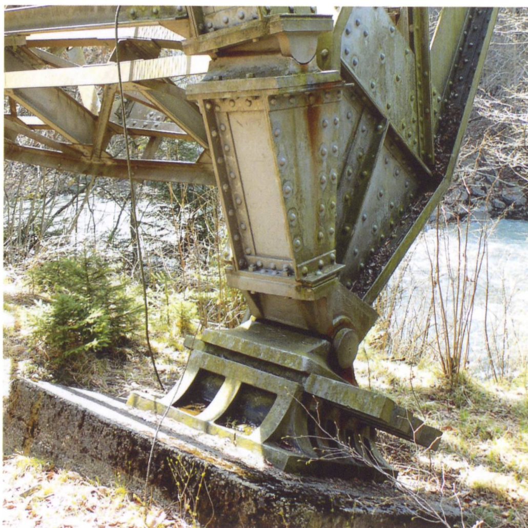
Kanderbrücke, das Widerlager auf Spiezer Seite. (Foto: Thomas Hurschler)
