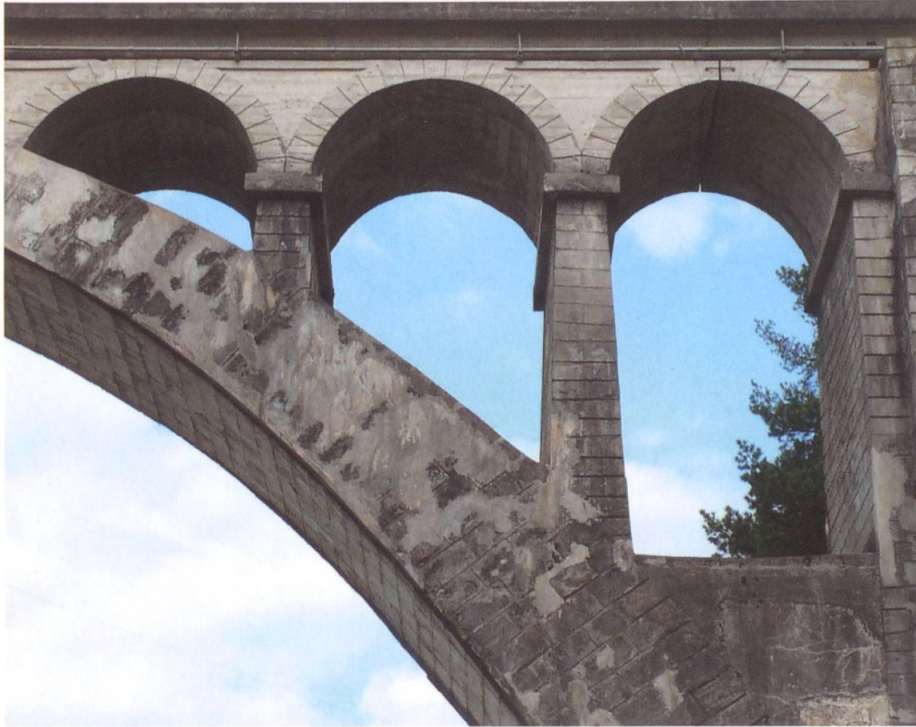
Kanderaquädukt, Detail des Hauptbogens. (Foto: Thomas Hurschler)
