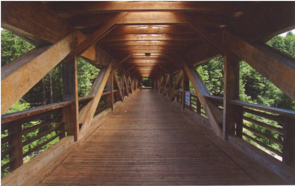
Die gedeckte Holzbrücke von 1989. (Foto: Rudolf Schneiter)
