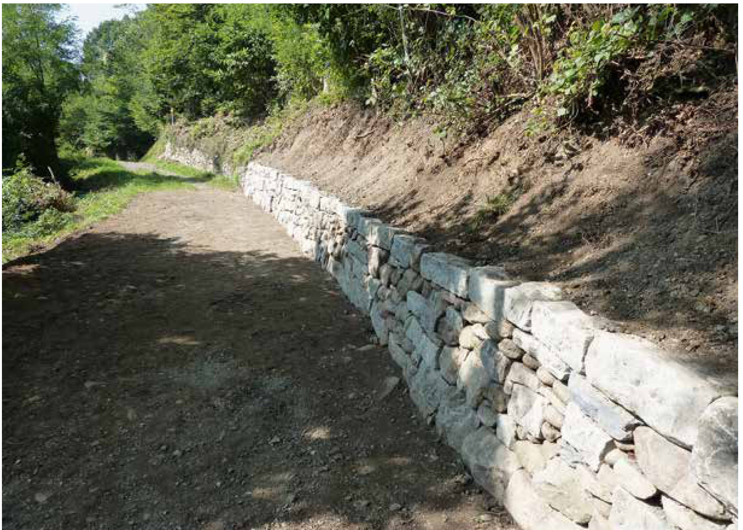
Situation nach dem Einsatz – wunderschöne Trockenmauer in hervorragender Qualität
