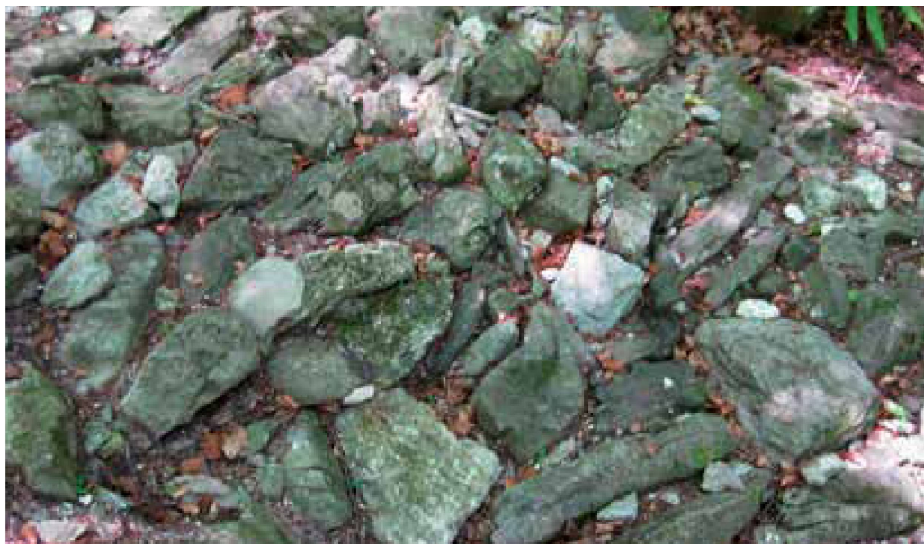
Abb. 13: senkrecht eingebrachte Pflasterung
