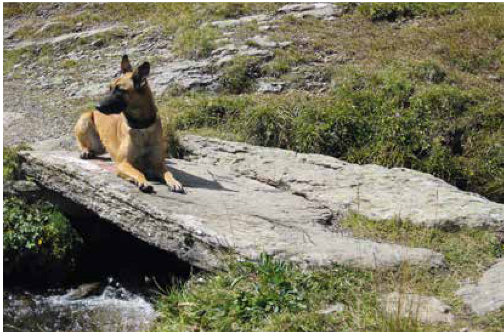
Abb. 16: Brücke am Faulhornweg (eine durchgehende Platte ca. 350–400 kg!)
