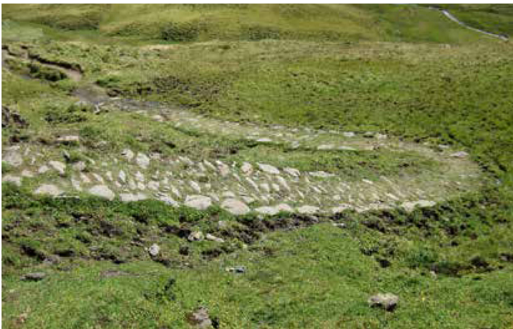
Abb. 15: Pflasterung Faulhornweg (Alp Bach)
