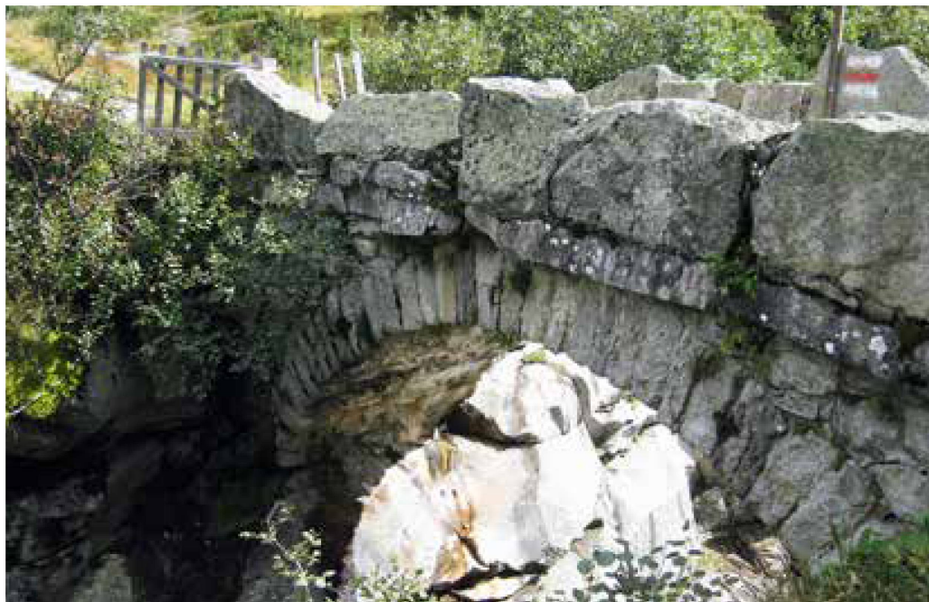
Abb. 7: Historische Brücke «Chüenzletännle» (Grimselweg)
