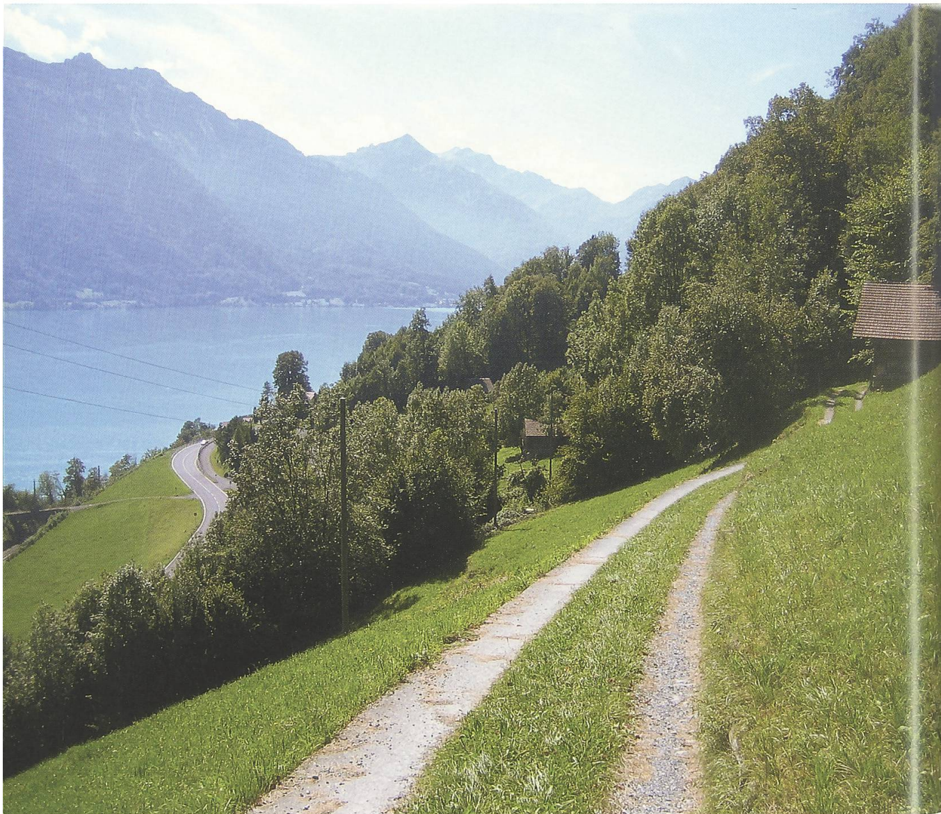
Erschliessungsweg hoch über Kantonsstrasse und Bahnlinie
