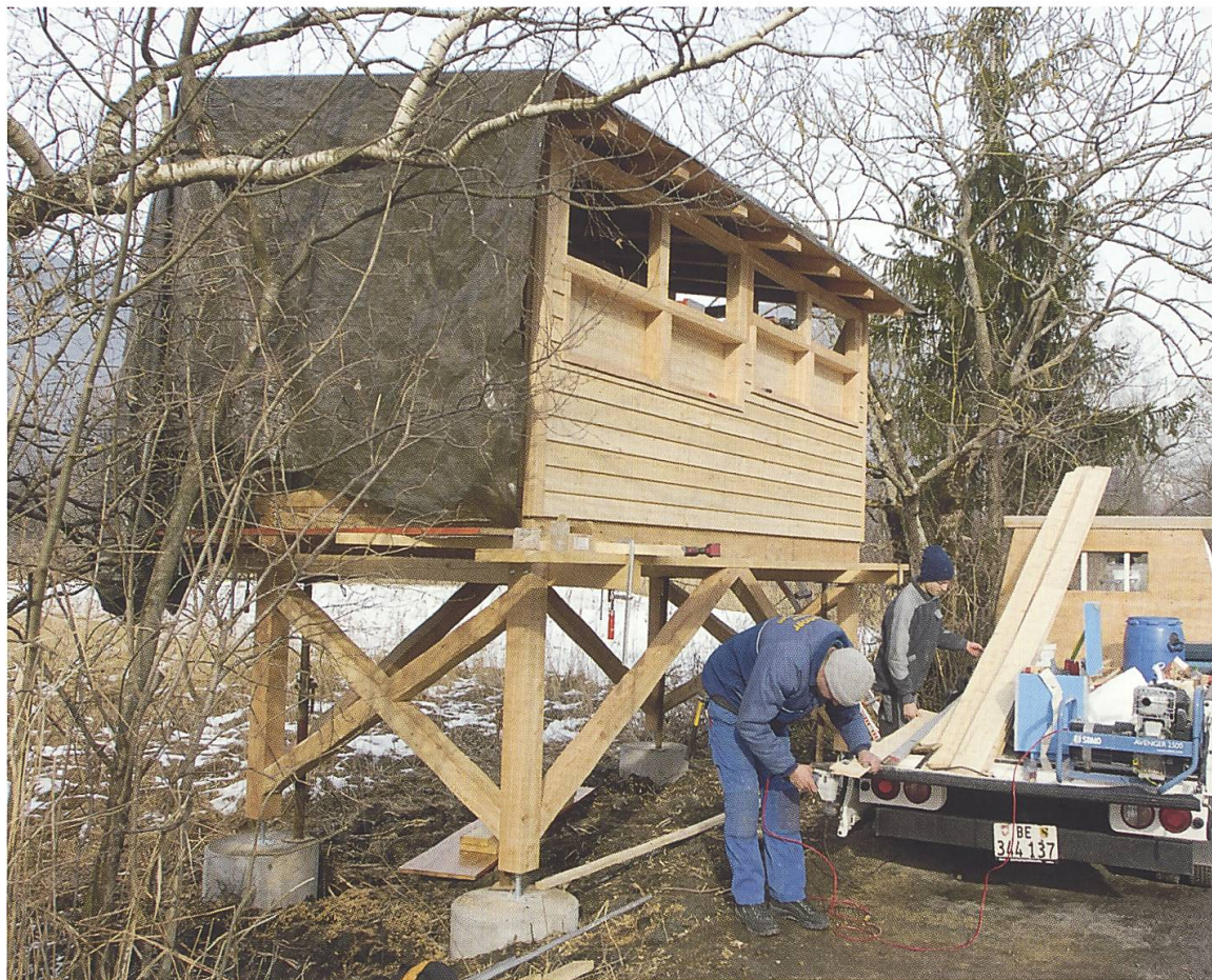
Hide-Aufbau: Die Zimmerleute der Gurtner Holzbau GmbH bei Aufrichten der Holzkonstruktion. Foto: Peter E Zingg
