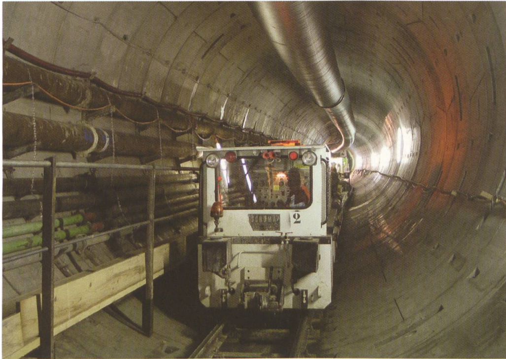
Abb. 4: Innenansicht des Stollens während der Bauarbeiten (Quelle: ARGE AHT)
