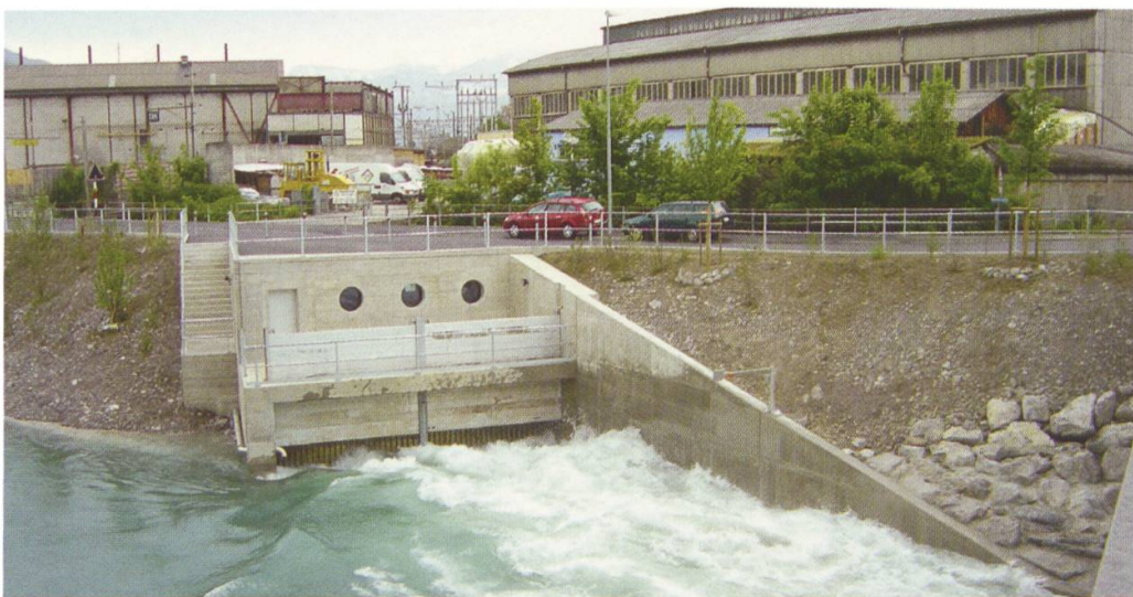
Abb. 5: Auslaufbauwerk bei einem Ausfluss aus dem Stollen von knapp 90 \text{ m}^3/\text{sec} während der ersten Tests (Quelle: IC)
