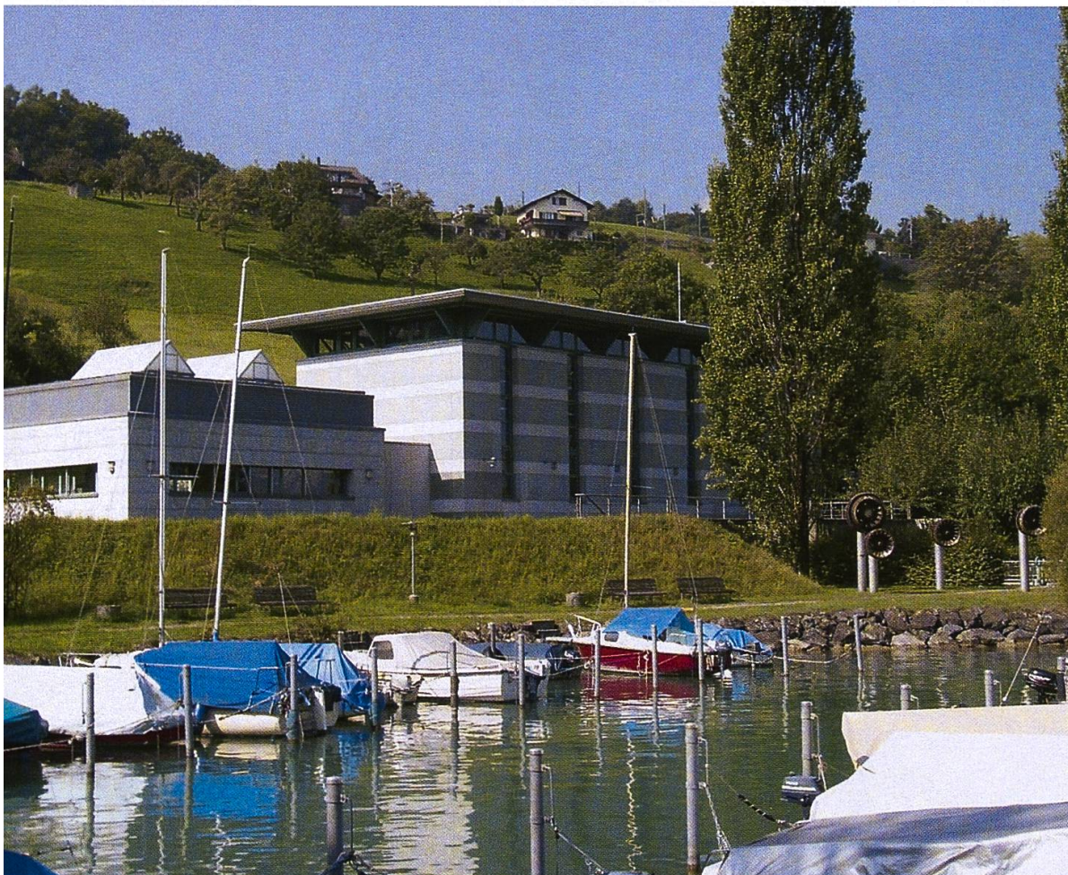
Turbinenhaus, Spiez, Foto: Hans-Ulrich Sieber, BKW
