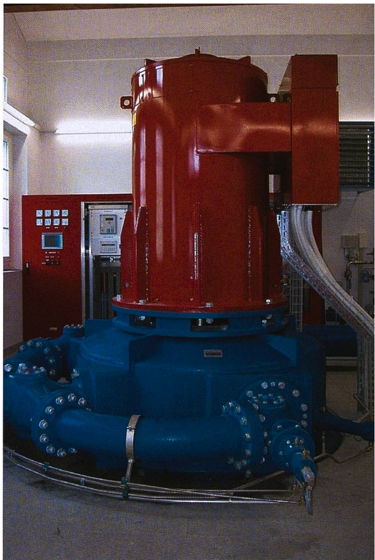
Turbinengehäuse mit Generator
