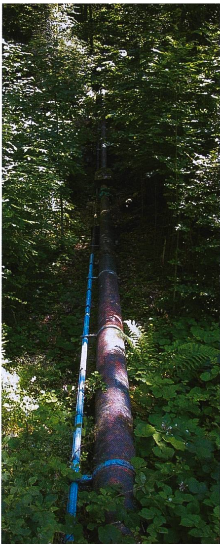
Oberirdische Druckleitung
