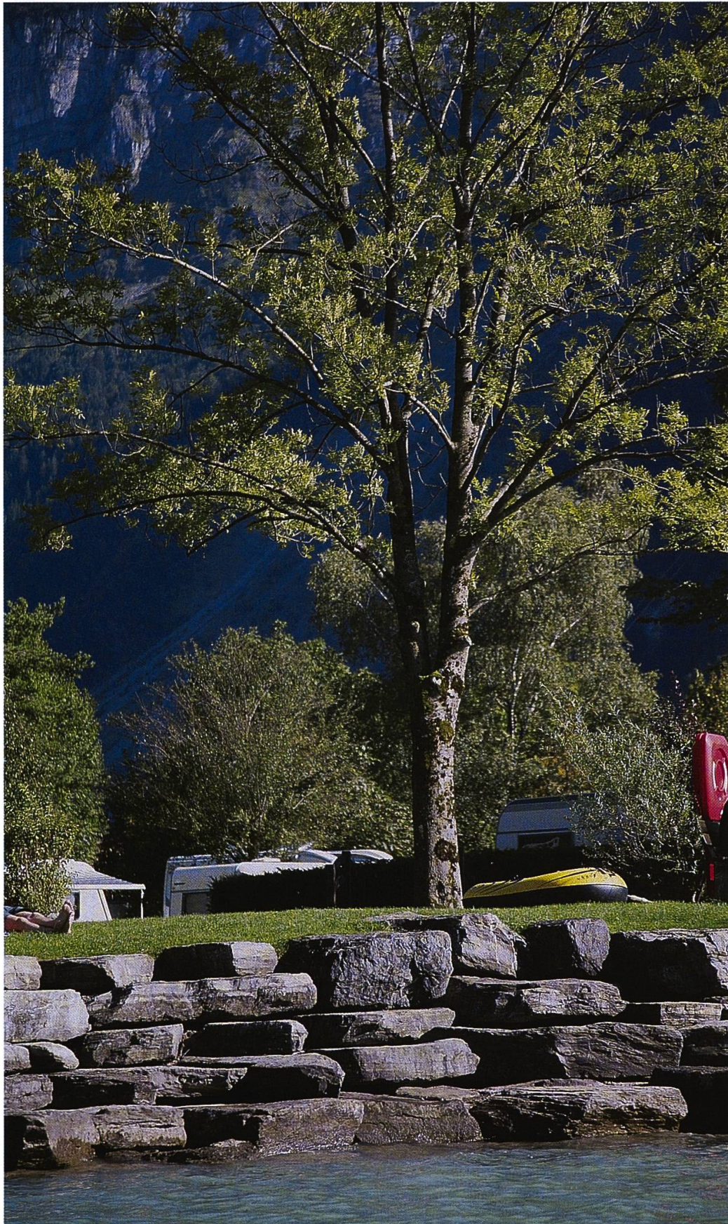
Treppenähnlich gestaltete Uferpartie
