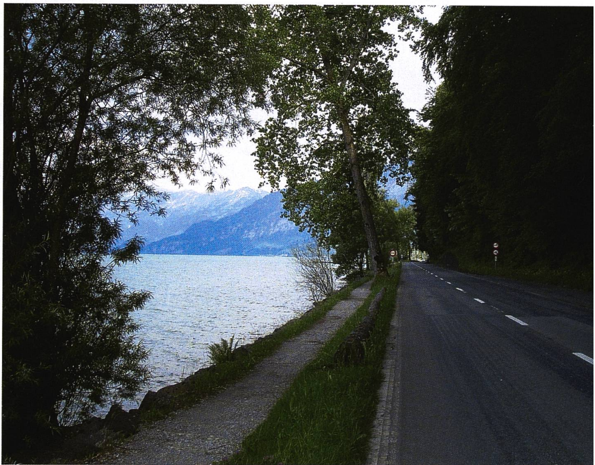
Alte Staatsstrasse zwischen Güetital und Faulensee mit Naturweg am See
