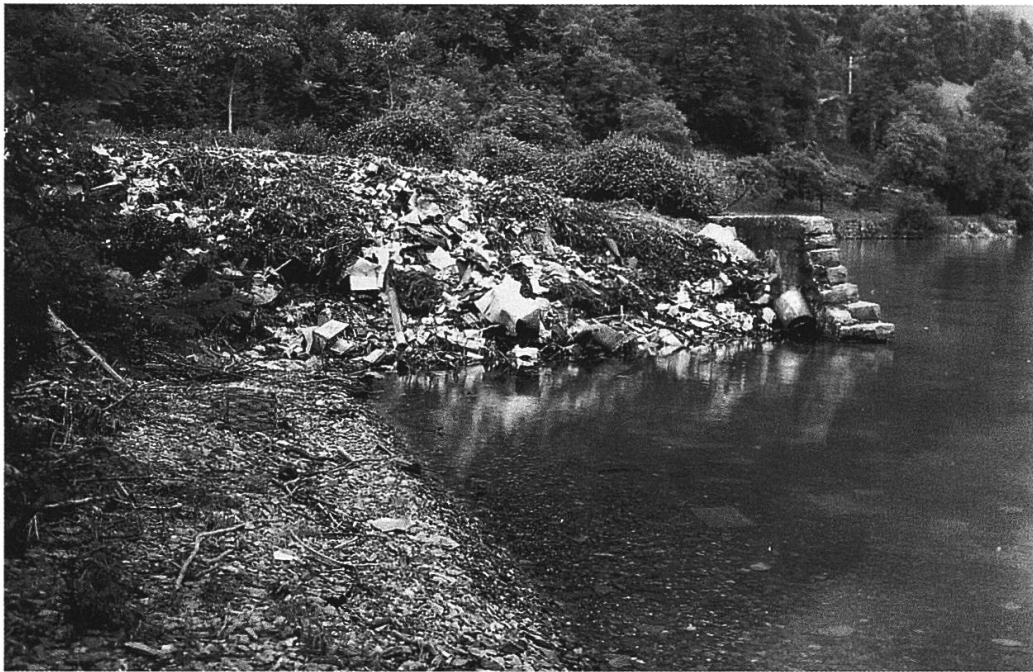
Kehrichtdeponie im See beim Wychel, Oberried
