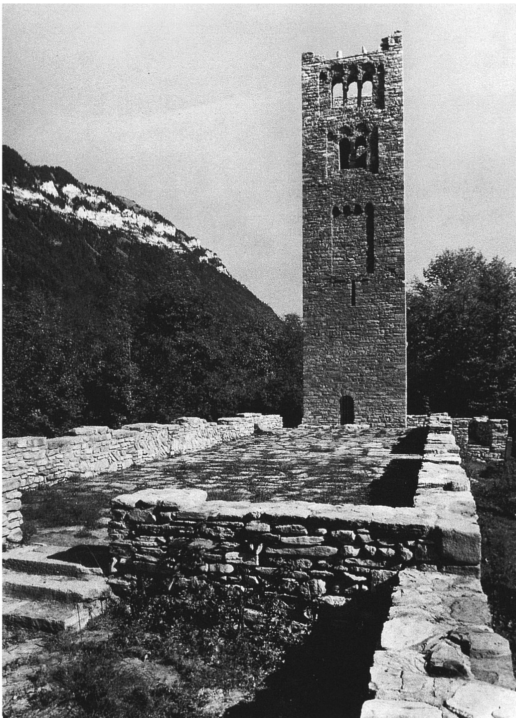
Kirchenruine Goldswil nach der Sanierung
