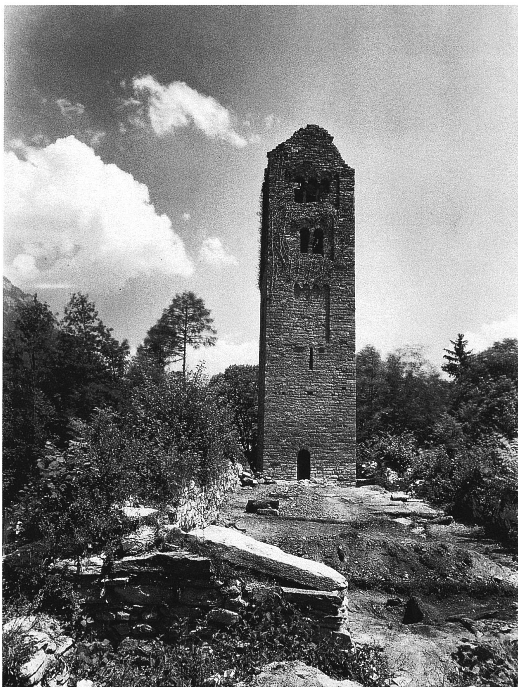
Kirchenruine Goldswil vor der Sanierung
