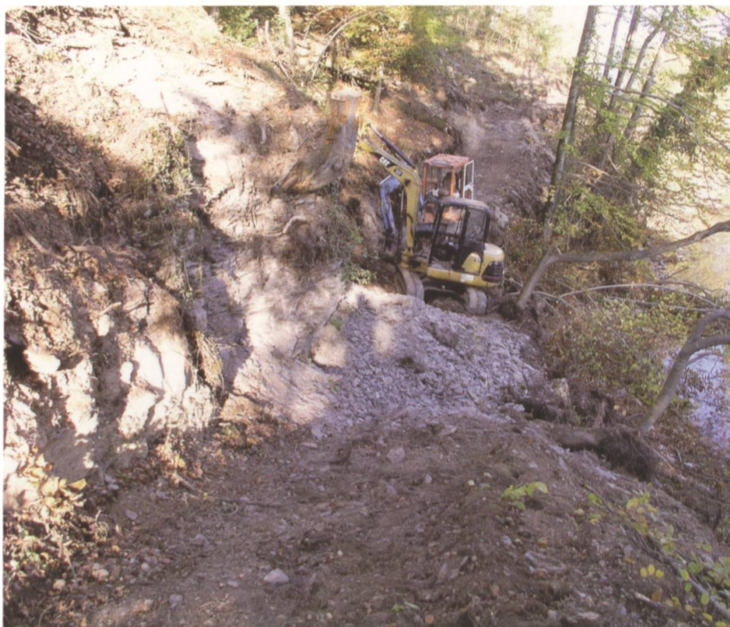
Bauarbeiten im Gebiet «Blatten»
