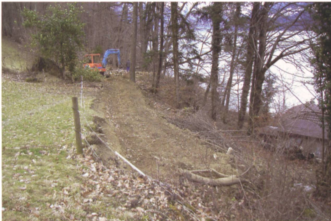
Bauarbeiten Gemeinde Ringgenberg
