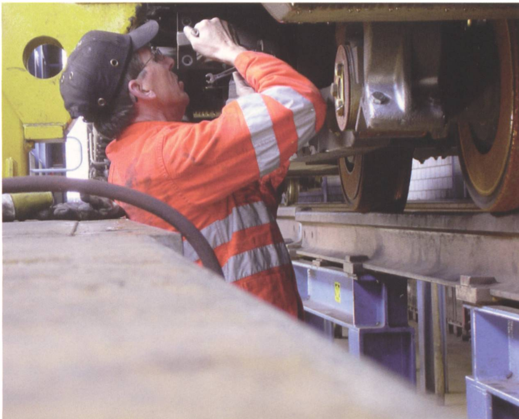
Kandersteg, Autopendelunterhalt vor Ort
