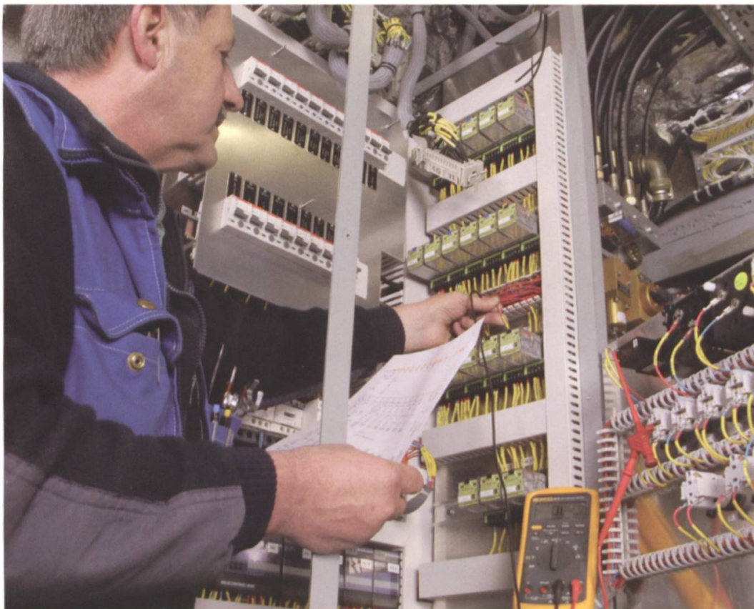
Elektriker bei Tableaumontage
