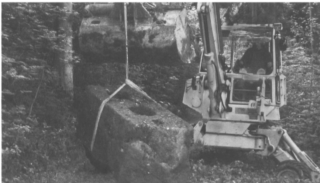
Stämpfelstein der Knochenstampfe in der Cholere Heiligenschwendi: Die Tiefe der Stampflöcher beträgt ca. 40 cm. Der von einem Hangrutsch verschüttete Granitstein (160/60/70 cm) wurde im Frühjahr 2007 aus dem Choleregraben geborgen. Foto: Georg Frank
