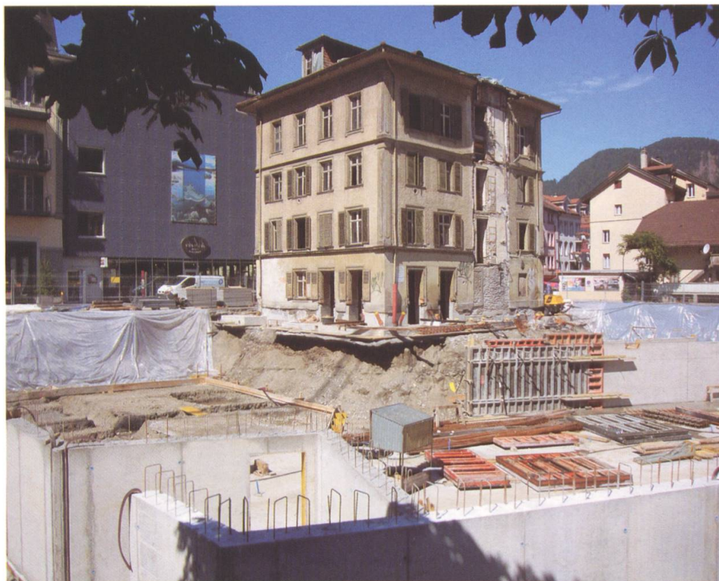
Bilder von der Baustelle. Fotos: Silvio Keller
