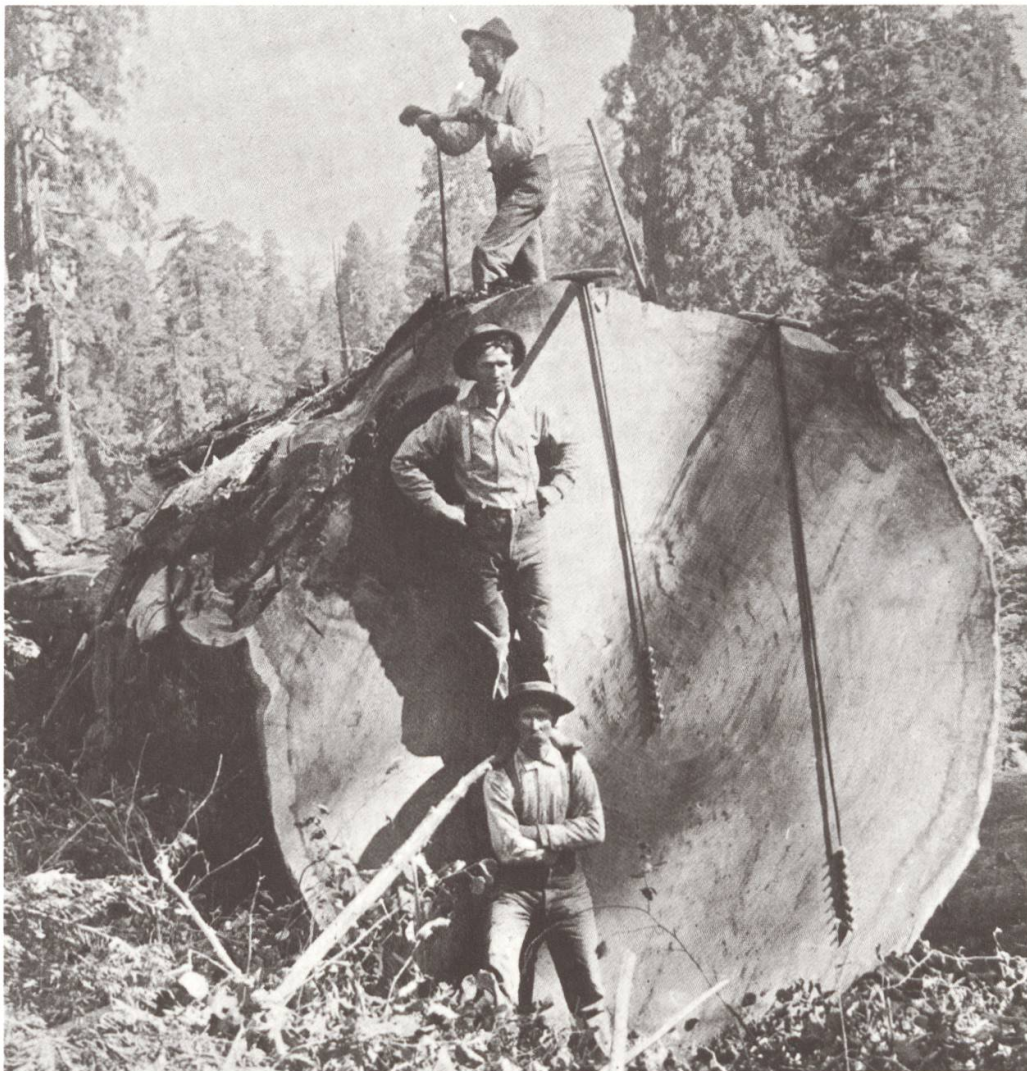
Abbildung 2: Als noch keine genügend langen Sägen zur Verfügung standen, wurden mit Bohrern Löcher in den Stamm gebohrt, diese mit Sprengstoff gefüllt, und der Stamm gesprengt. Die Holzer nannten diese Art des Fällens «Blasting a big Stick»; aus: Johnston (1996) p. 45
