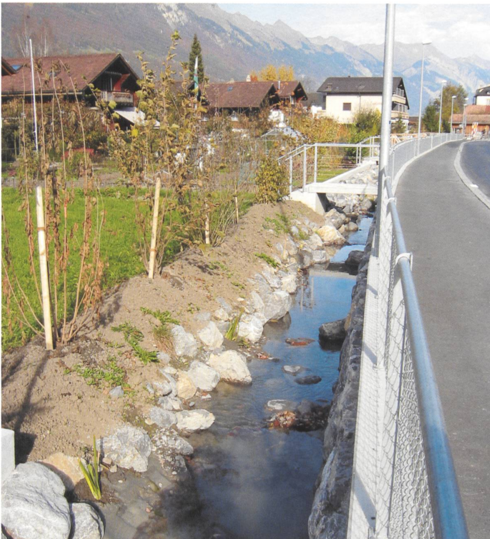
Das sanierte Trottoir; nordseits des Baches vom Anwohner gestalteter Abschluss
