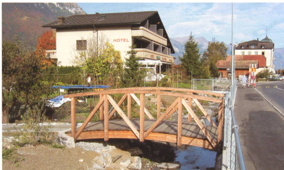
Eines der neuen Holzbrücklein zu den Anwohnern
