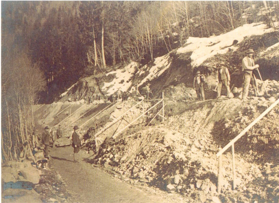
Februar 1920: Verbreiterung der Habkernstrasse im Bereich Schufelegg. (Foto: zvg)
