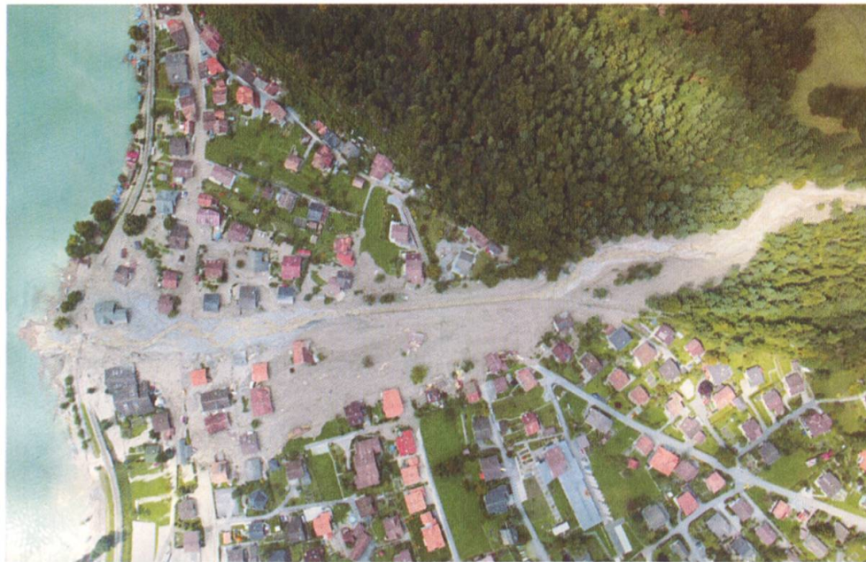
Abb. 6: Flugaufnahme des Unterlaufs und der Schale des Glyssibaches nach dem Murgang vom 23. August 2005 (Abt. Naturgefahren 2004)
