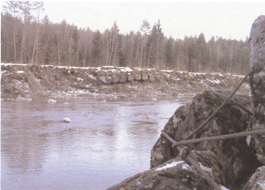
Vor der Renaturierung: Die Kander hat sich eingefressen und die beidseitigen Buhnen unterspült.
