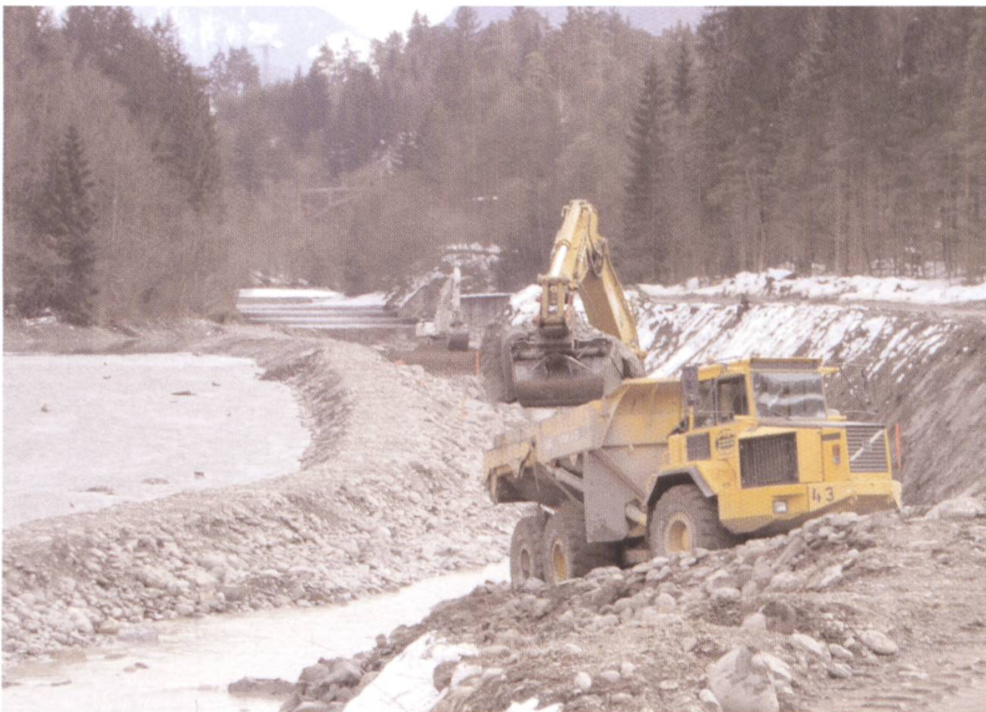
Die Blockrampe im Bau: Während der linke Teil erstellt ist, wird rechts mit schwerem Gerät gearbeitet.
