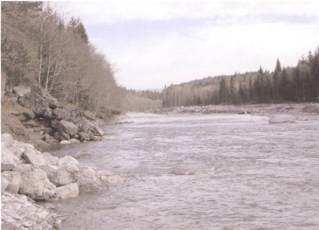
In einer zweiten Bauetappe wird im Winter 2005/06 das Kiesmaterial rechts abgetragen um der Kander Raum zu geben.
