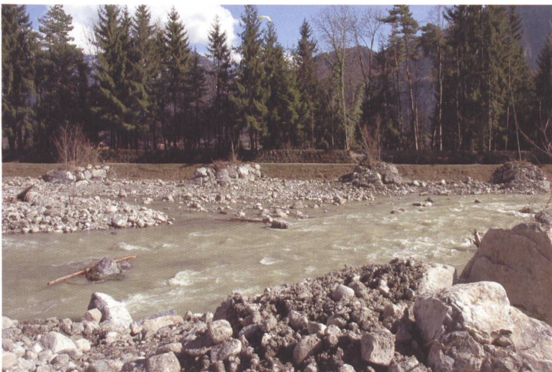
Blockbuhnen am linken Ufer im Bereich der Aufweitung. Sie sollen die Hauptströmung des Baches gegen die Mitte lenken und eine Unterspülung der Schalenmauer verhindern.
