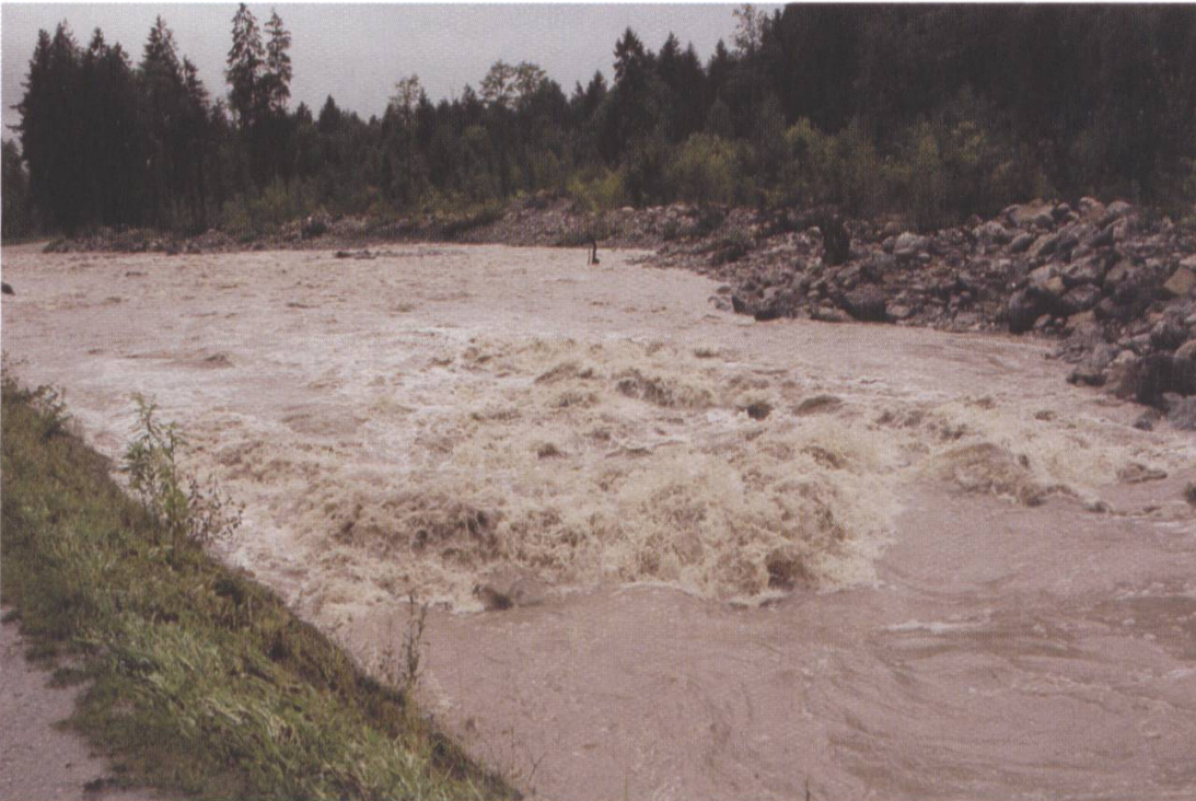
Am 22./23. August 2005 hatte sich die Aufweitung bei Hochwasser zu bewähren. Sie erfüllte die in sie gesetzte Erwartungen.
