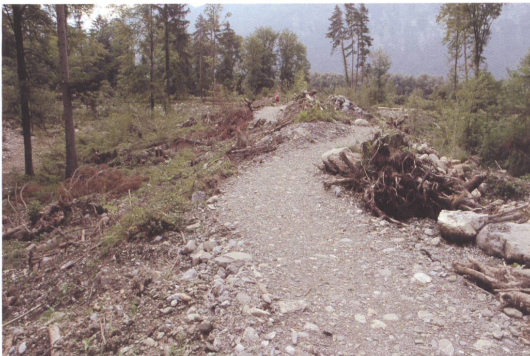
Der aufgeschüttete 165 m lange und bis zu 5 m breite Querdamm wurde mit Kalk verfestigt. Foto: Ueli Flück
