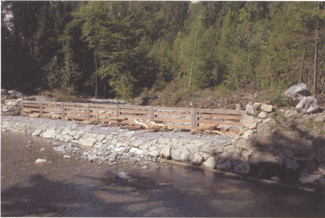
Durch diesen Einlauf (Streichwehr) soll der hochgehende Lombach in die Überflutungszone «Hindere Eywald» fluten.
