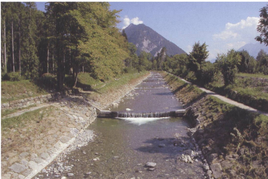
Oberhalb der Neuhausbrücke: Angrenzend an die Fusswege wurden Hochwasser-Schutzdämme aufgeschüttet. Foto: Ueli Flück
