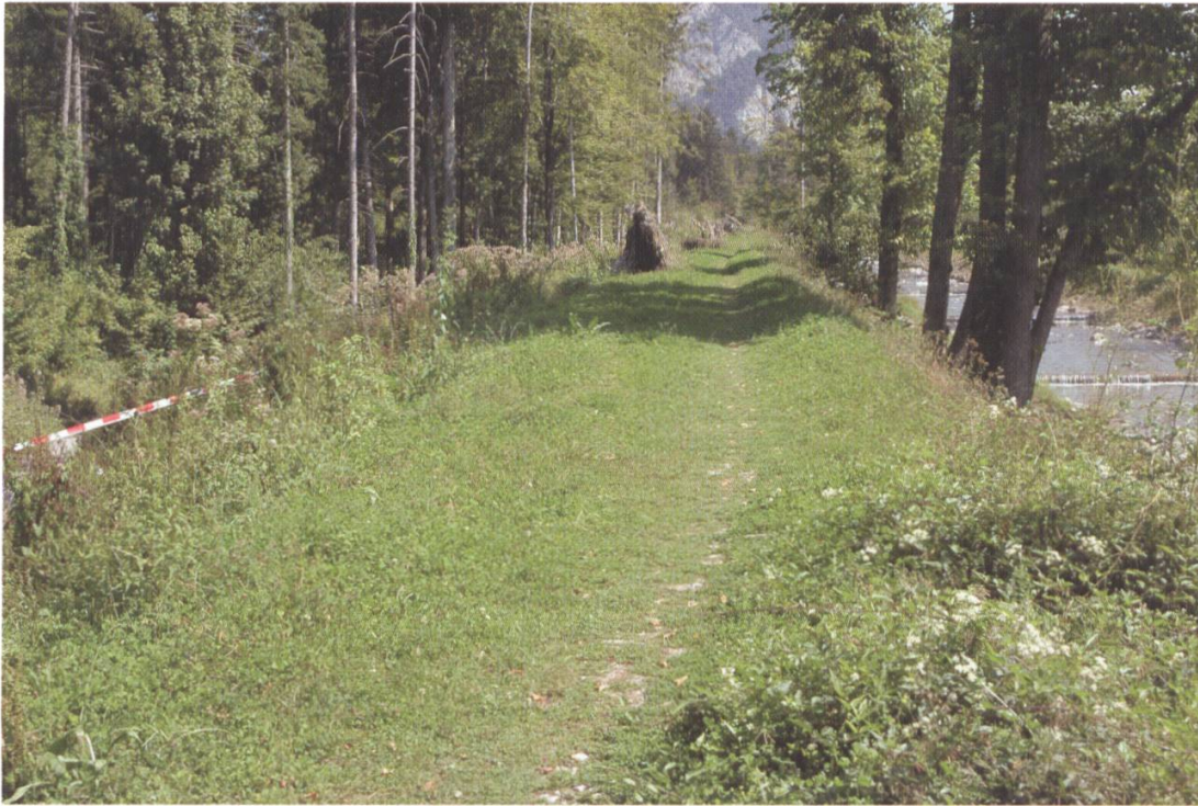
Begrünter neuer Damm oberhalb der Neuhausbrücke (rechtes Ufer). Die Dämme dienen künftig auch als Reckwege. Foto: Ueli Flück
