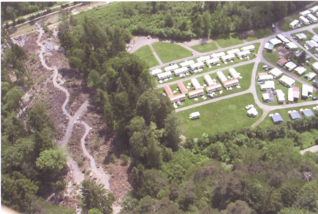
Ein Querdamm am Ende der Überflutungszone schützt den Campingplatz vor Hochwasser. Foto: Fritz Bettschen
