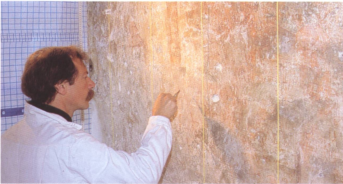
W. Ochsner 1989 an der Westfassade
