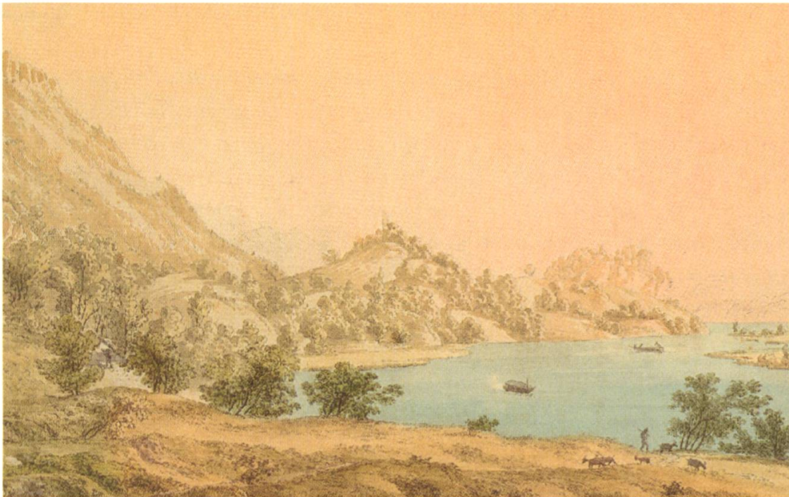
Abb. 1: Johannes Stähli Brienz 1778–1861 Habkern : Goldswyl am Brienzersee. Kolorierte Umrissradierung. Auf dem Hügel in der Mitte die Ruine der Kirche von Goldswil, am Bildrand rechts und unten, der Ausfluss des Brienzersees in die mäandernde Aare. Standpunkt des Künstlers: Höhe Interlaken-Ost. 1
