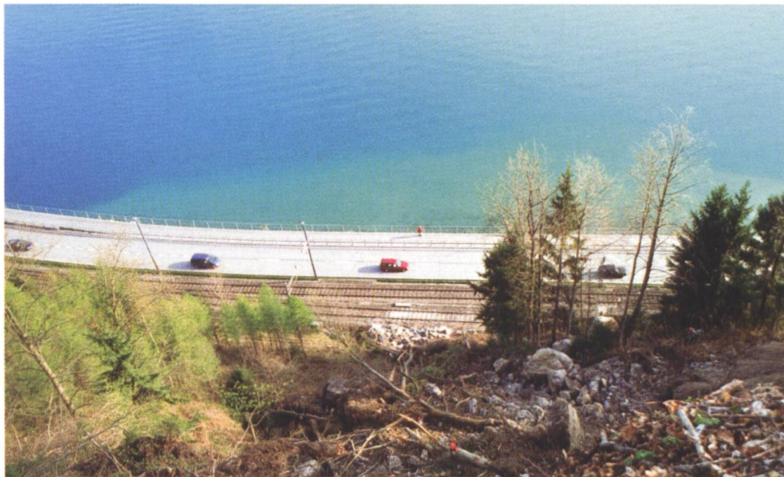
Felssturz vom 16. April 1999. Blick von der oberen Abbruchkante auf die Bahnlinie BLS und die N8. Foto: U. Vogt
