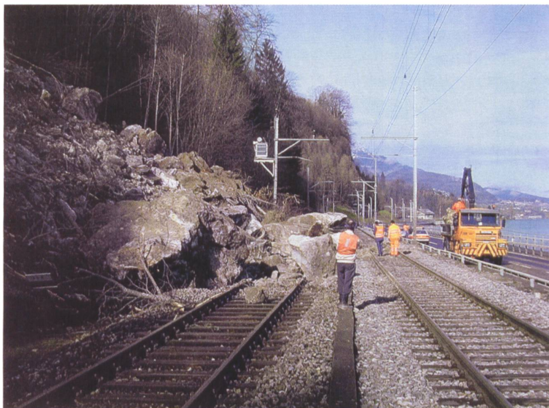
Felssturz vom 18. März 2001. Foto: BLS
