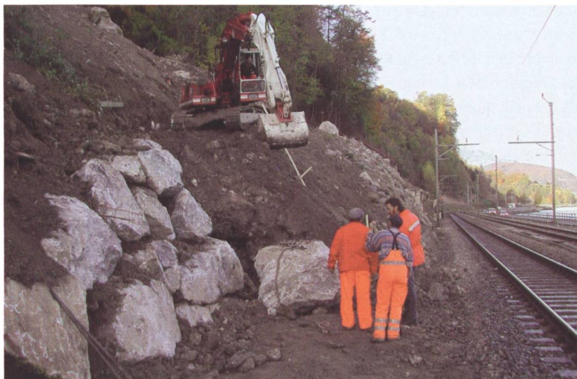
Bauarbeiten am Schutzdamm nach dem Felssturz vom 18. März 2001. Foto: B. Perren
