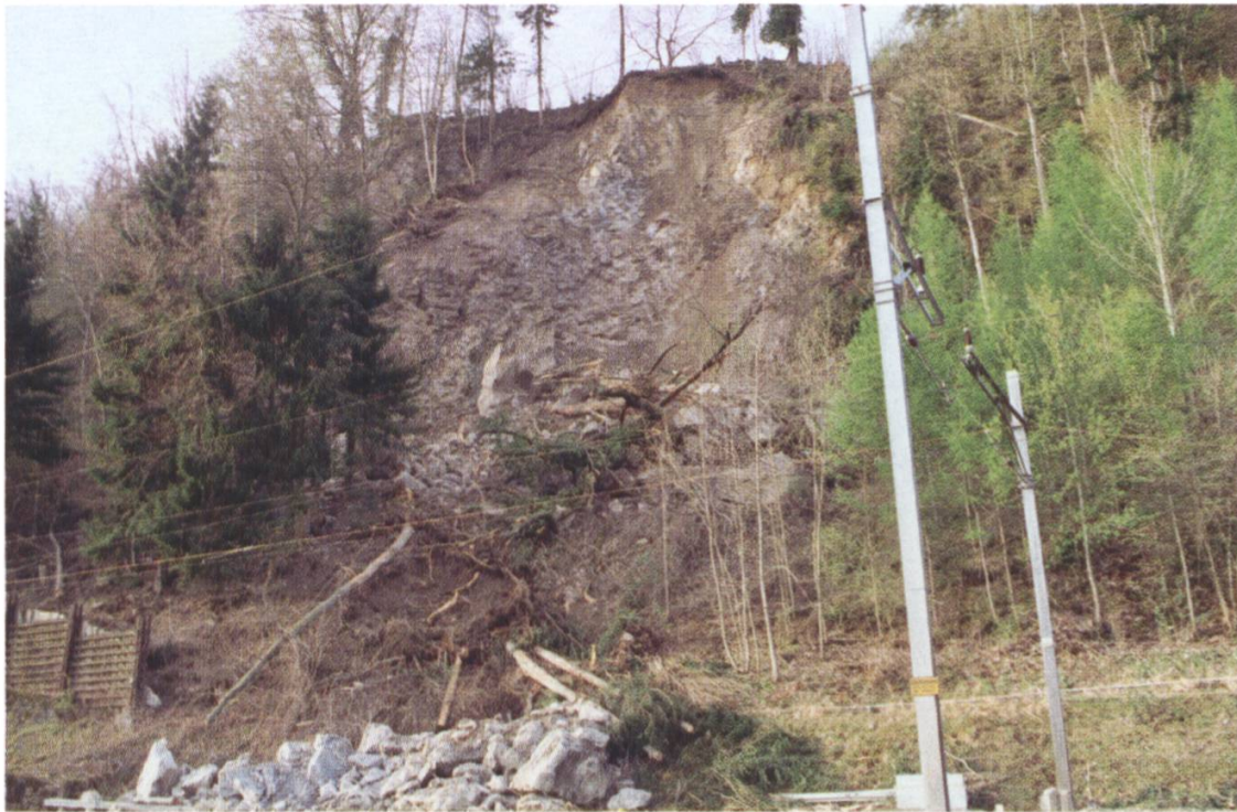
Felssturz vom 16. April 1999. Foto: U. Vogt
