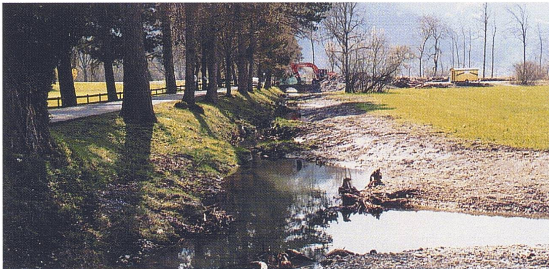
Der unter Anleitung des Fischereiaufsehers renaturierte Weissenaukanal präsentiert sich nach der Renaturierung bis zur Autobahnquerung als attraktives Gewässer für Fische mit zahlreichen Verstecken und Kleinstrukturen. Im Hintergrund wird der fischgängige Durchlass zum Parkplatz Weissenau erstellt. Foto A. Bossert, April 1999.
