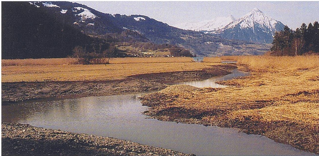
Der wiederhergestellte Aare-Altlauf kurz nach Abschluss der Bauarbeiten im März 1998. Es sind eine ganzjährig durchgehende Verbindung zum See und zahlreiche Stillwasser als Brutnischen für Wasservögel entstanden. Foto A. Bossert März 1998.
