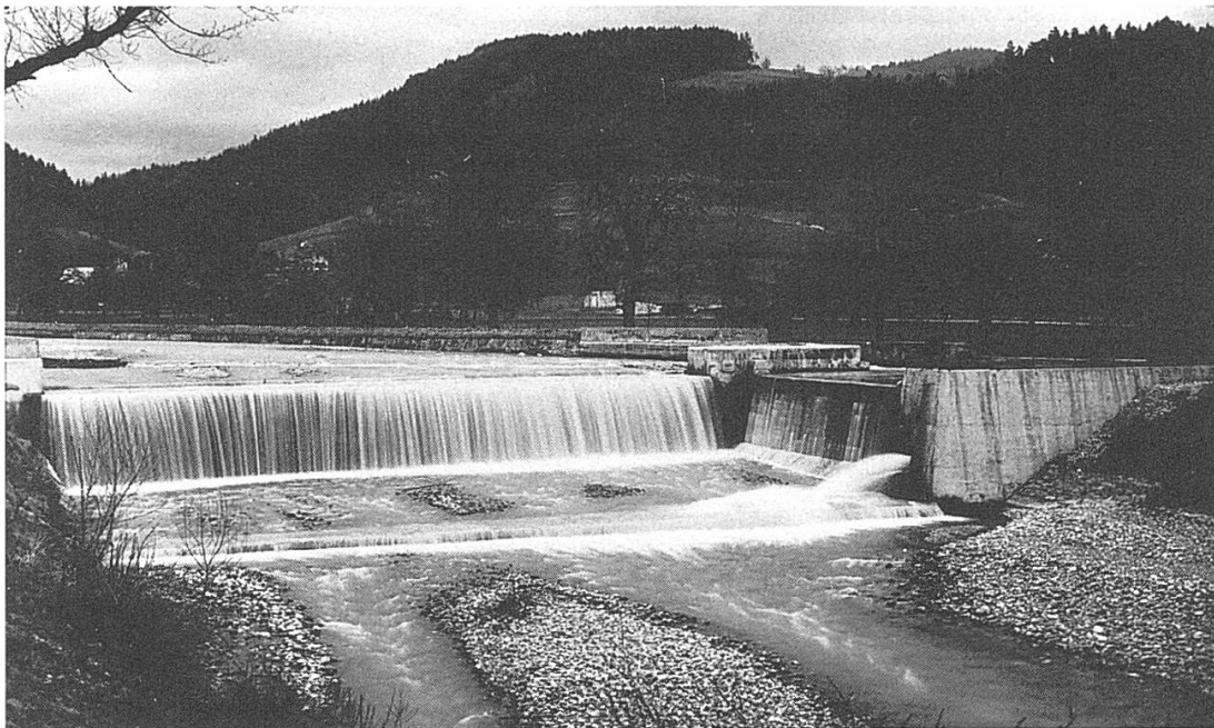
Müllerschwelle nach der Fertigstellung, 1909
