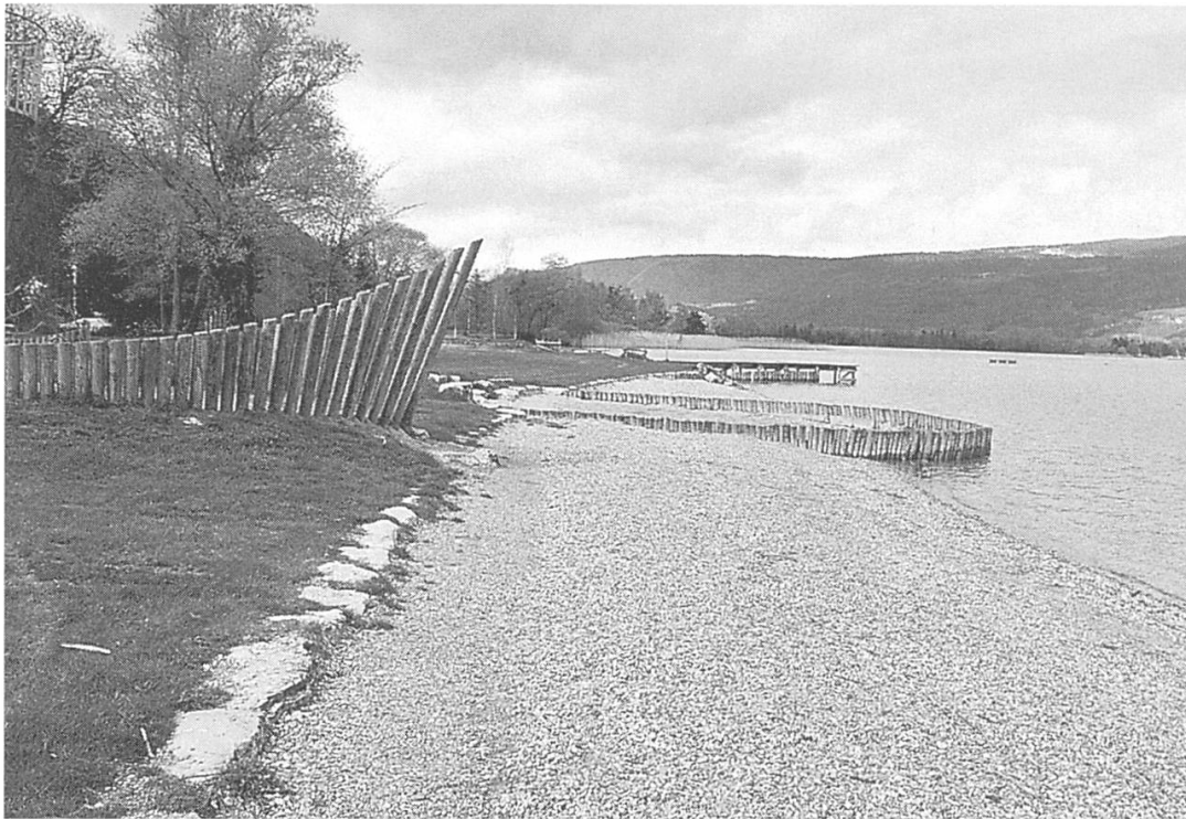
Ein Projekt für den Menschen: Aus einer Blocksteinmauer wird ein Flachufer (Erlach)
